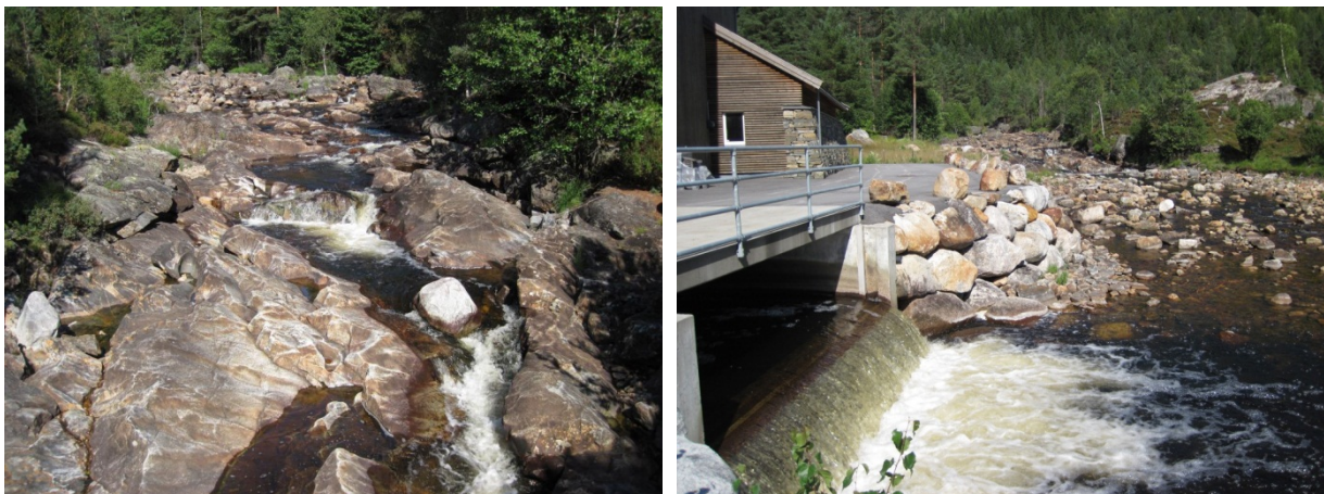
Parti fra Skjerka ovenfor kraftstasjonene med strie stryk og svaberg (t.v.) og utløpet av Uleberg kraftverk (t.h.).
