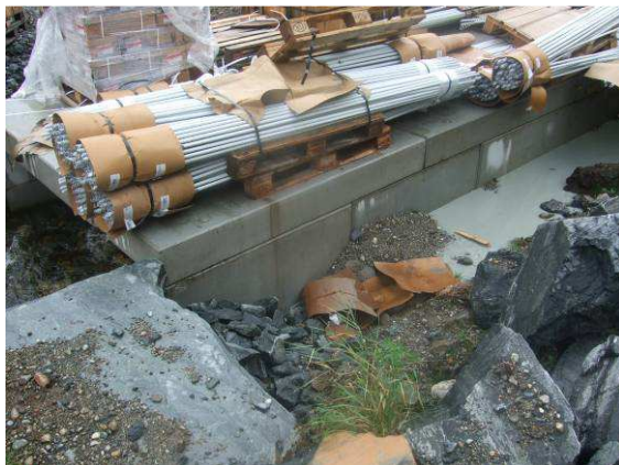
Figur 13 Kulverten i Kattaråa i anleggsfasen 2010.
