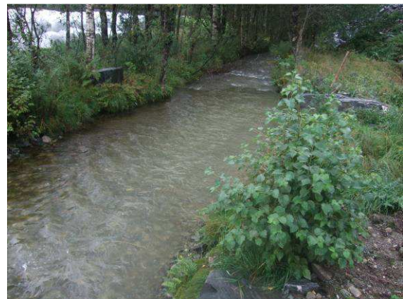
Figur 14 Strekingen mellom kulverten og stasjon 6 med stor vannføring. Det eksisterende sedimentet ble dekket til med material fra anleggsplassen i 2010.
