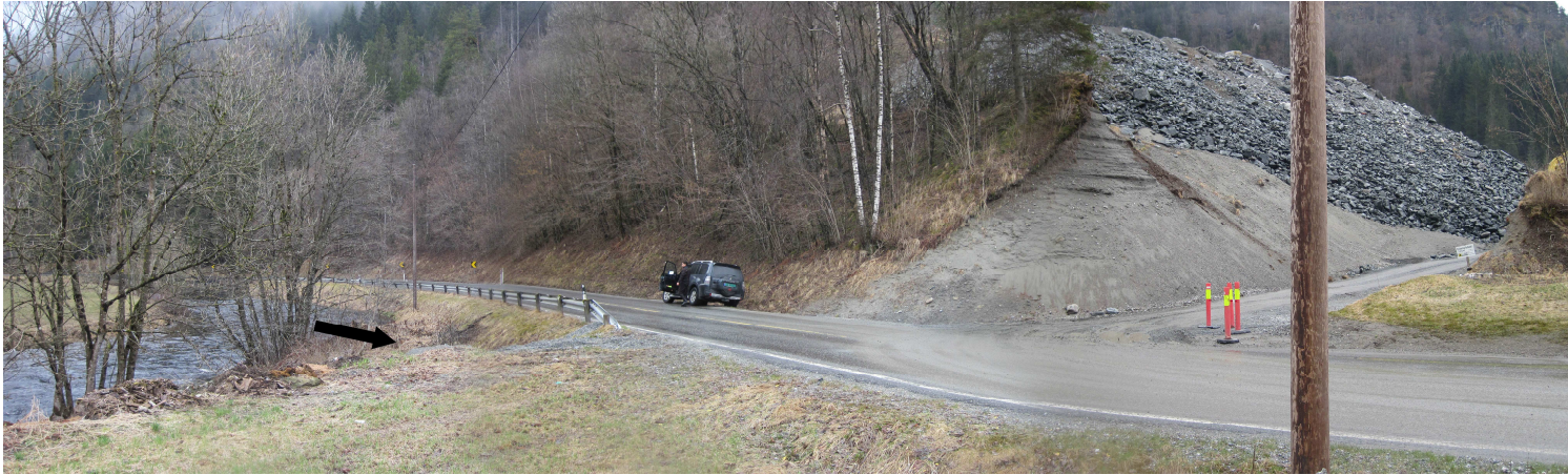
Figur 19 Stein- og løsmassedeponi ved Skorvo. Spor etter finsedimenttransport til Granvinselva er godt synlig. Bilden nedenfor ble tatt ved den svarte pilen.
