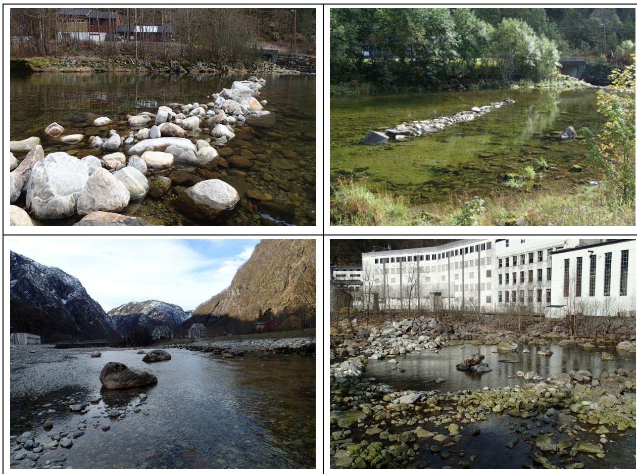
Bilde 6. Øverst: Ledebune/steingruppe for å øke vannhastigheten for det nyetablerte gyteområdet samt skape skjulesteder for ungfisk. Nederst: Steingrupper og dypere områder (kulper) danner standplasser for gytefisk samtidig som de fungerer som skjulesteder for ungfisk.
