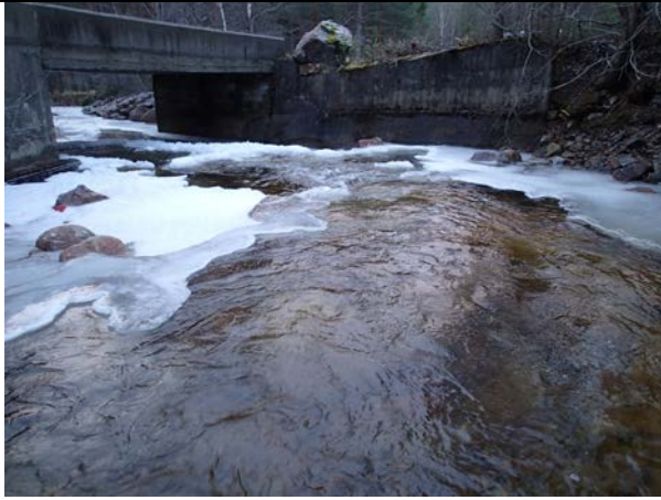
Fjellskaråa ved broen (st. 15)
