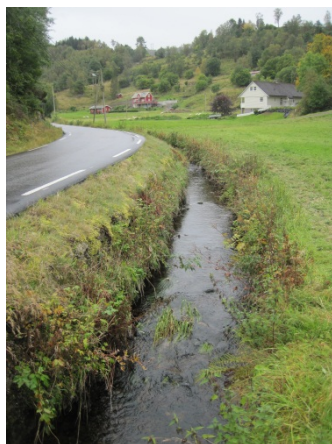
Figur 2 Bekken er delvis uttrettet og kanalisert, og kantvegetasjon er fjernet
