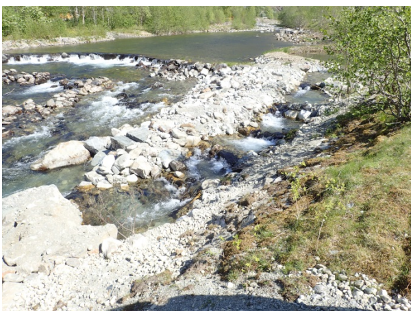
Eksempel for fiskepassasjer: Venstre bildet viser et «natur lik» passasje inn i en sidebekk i Aurlandsvassdraget («nature like bypass»). Høyre bildet viser en spaltetrapp i Akerselva i Oslo («vertical slot pass»).
