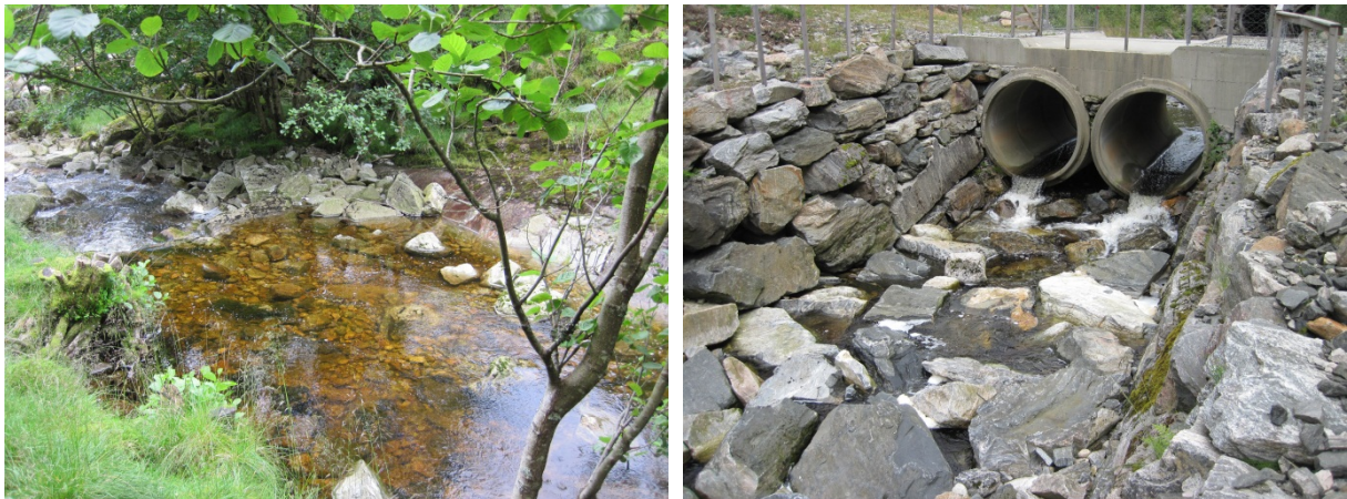
Figur 10 Nedre Kleivelandsbekken fremstår som et lite forandret og produktiv sjøaurehabitat. I øvre anadrom del virker en veikulvert som vannføringsavhengig vandringshinder, og plastringen nedenfor er så overdimensjonert at vannet sildrer mellom steinene ved normal vannføring. Hydraulisk sett vil en steinterskel gi samme stabilitet, men med mindre kostnader og en mer naturlig elvebunn.
