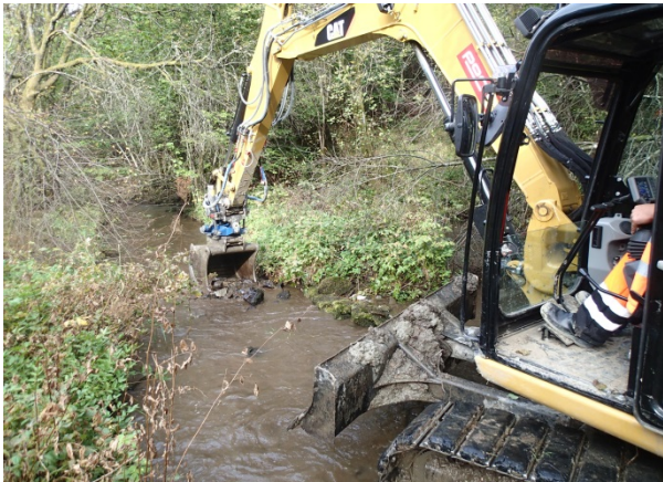
Harving av elvebunn (bare juli-september!) for å øke skjul gjennom fjerning av finsediment og armeringslag. På høyre bildet: Utlagt gytegrus for å bedre gyteforhold for sjøaure. Begge eksempler fra Apeltunvassdraget.
