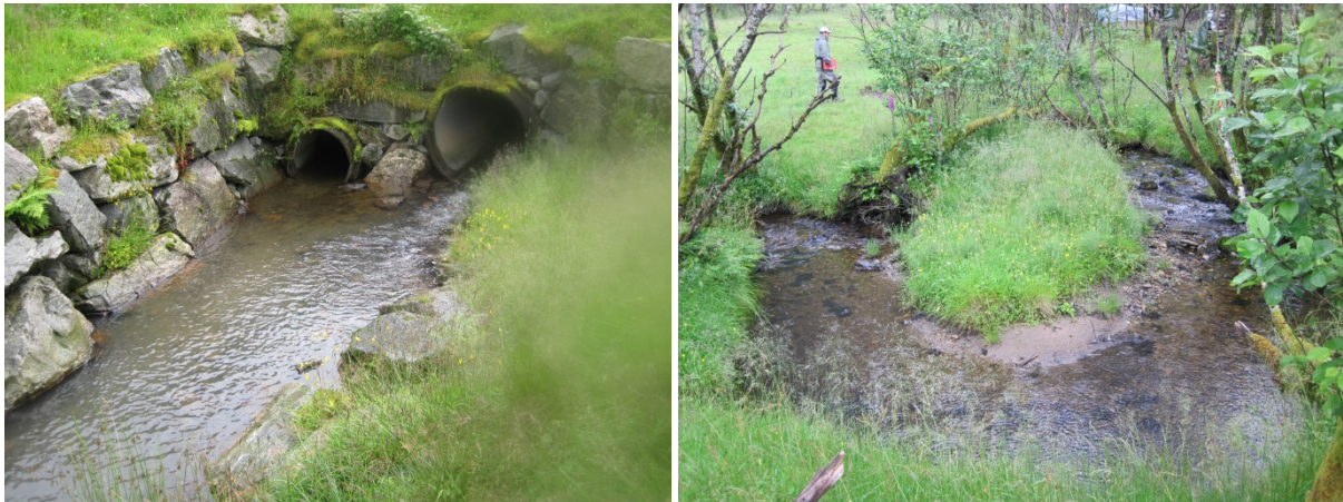
Figur 28 Rundt 10 % av vassdraget er lagt i rør. Rørene vurderes som passerbare for fisk ved flomvannføring grunnet lav gradient, men arealet er tapt for fiskeproduksjon. Øvre del av løpet mot sør er ikke utrettet eller forbygget, og har gunstige habitatbetingelser for fisk med mye skjul og gyteplasser.
