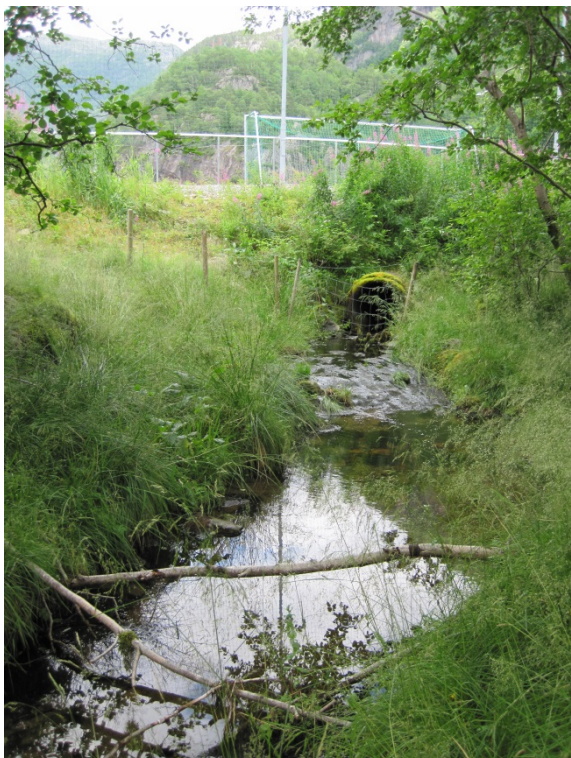
Figur 32 Øvre enden av Drivo (rør under idrettsbane)
