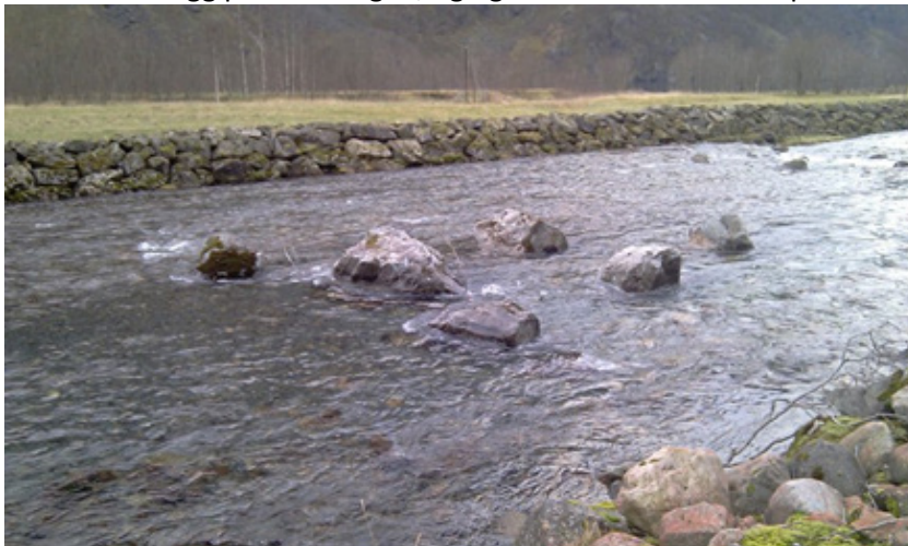
Bilde 3. Steingrupper lagt ut i samløpet i Osa i 2011. Bilde fra Statkraft.
