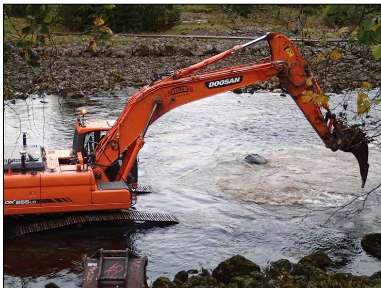
Figur 4: Harving av bunnsubstrat vha. gravemaskin (Aurlandselva).
