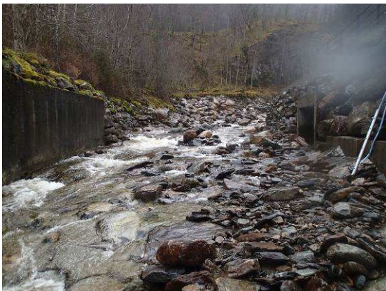
Figur 37 Klokken 13:16: Vannet har rent over inntaksdemningen, nedover elveløpet i restfeltet, og har kommet fram til kraftutløpet
