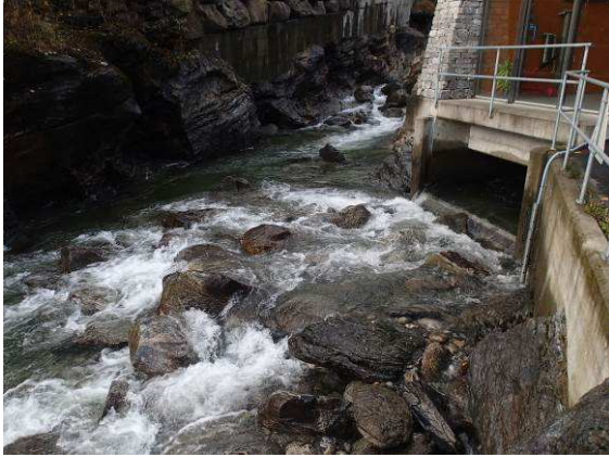
Figur 21 Klokken 10:30-10:33: Kraftutløpet rett etter nødstop. Turbinene står, hovedventilen er stengt og omløpsventilen leverer vann.
