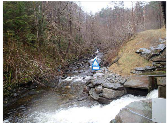
Figur 11 Klokken 13:55: Kraftverket er i drift igjen. Overløpsbølgen har fremdeles ikke kommet ned restfeltet.
