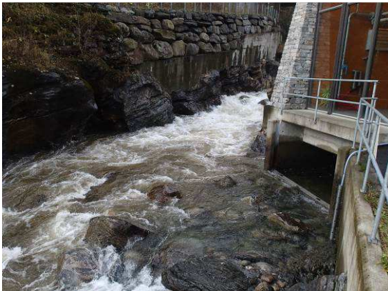
Figur 23 Klokken 11:05-11:30: Vannet renner over inntaksdemningen, ned restfeltet og har kommet fram til kraftutløpet
