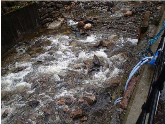
Figur 35 Klokken 12:40-12:49: Kraftutløpet etter nødstop. Turbinene står, hovedventilen er stengt og omløpsventilen leverer vann.
