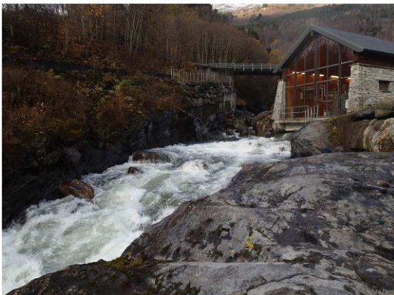
Figur 17 Dalsdalselvi og Kvåle kraftverk kl. 10:20 den 30.10.2014
