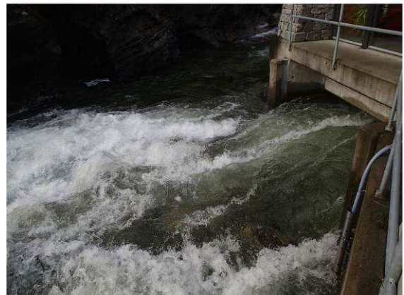
Figur 18 Kraftverket går på 100 % og leverer ca. 5 MW (tilsvarende ca. 5 m 3 /s)
