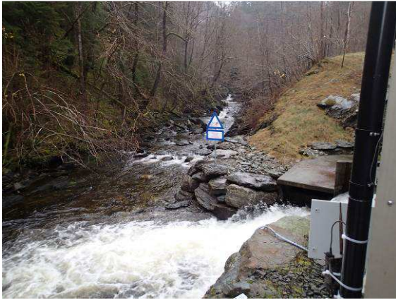
Figur 8 Utløpet av kraftverket ved 100 % kraftverksdrift 3.11.2014 12:50
