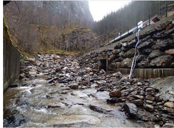
Figur 36 Klokken 12:49-13:15: Omløpsventilen leverer knapt vann. Vannføringen nedenfor kraftverket stammer nå bare fra tilsiget i det gamle elveløpet opp mot inntaksdemningen, deler av elvebunn er tørrlagt.
