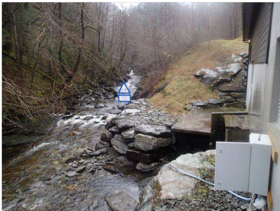
Figur 10 Klokken 13:18 Omløpsventilen leverer ikke lenger vann. Vannføringen nedenfor kraftverket stammer nå bare fra tilsiget i restfeltet. Vannet ovenfra har ikke rukket å renne over demningen og ned restfeltet. Deler av elvebunn nedstrøms kraftverket er tørr.
