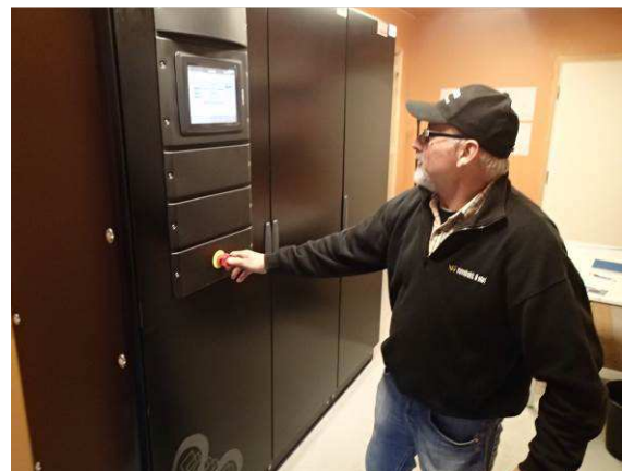
Figur 34 Jan Rasdal stopper kraftverket kl. 12:39
