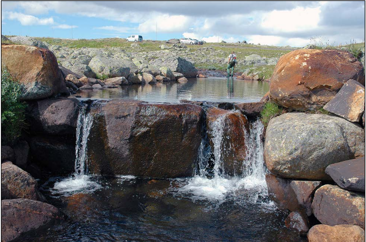
Figur 15: Vandringshinder for ørekyt, utformet som terskel med loddrett fall. Halnebekken, 2007.
