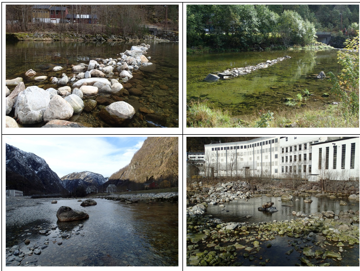
Bilde 2. Øverst: Ledebune/steingruppe for å øke vannhastigheten for det nyetablerte gyteområdet samt skape skjulesteder for ungfisk. Nederst: Steingrupper og dypere områder (kulper) danner standplasser for gytefisk samtidig som de fungerer som skjulesteder for ungfisk.
