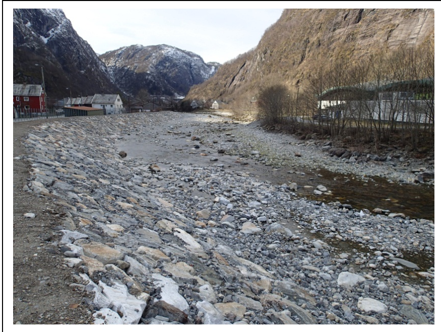
Bilde 3. Deler av restfeltet slik det så ut etter at flomsikringsarbeidet var ferdig i 2014. BKK er pålagt et vannslipp på 300 l/s fra Storefossen som opprettholder noe av det vanndekte arealet.
