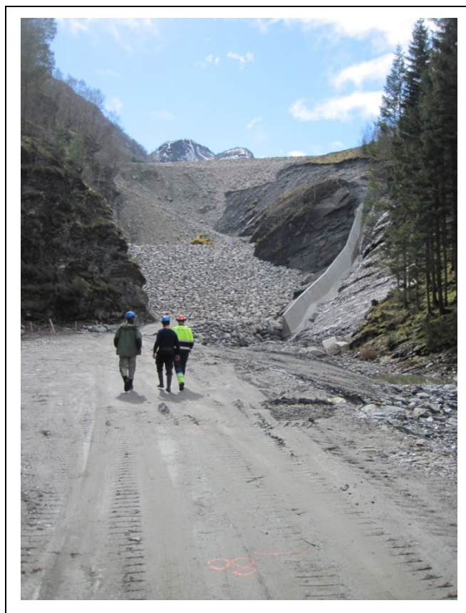
Bilde 9. Restaurering av Refsdal dam.
