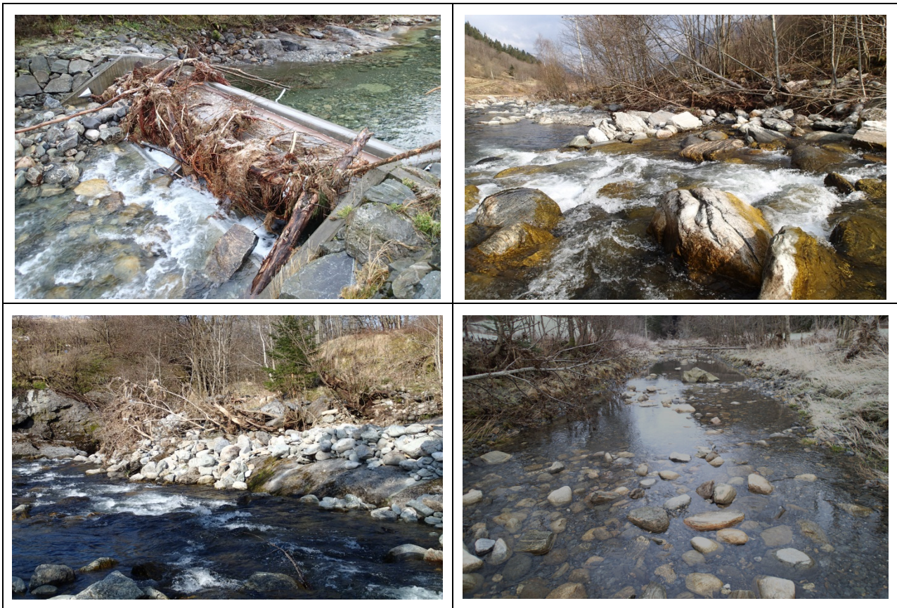
Bilde 15. En stor flom i oktober 2014 endevendte store strekninger av elvebunnen i restfeltet. Smoltfellen ble skadet og flomvannet etterlatte seg store mengder masser både i forkant og bakkant av fellen. Bunnssubstrat fra elva ligger på land flere steder.
