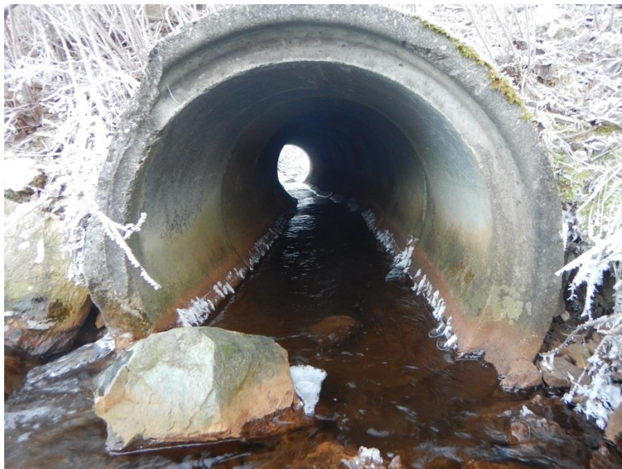
Fig. 12 Innsyn inn i siste kulvert før strykparti ned mot Stekervika.
