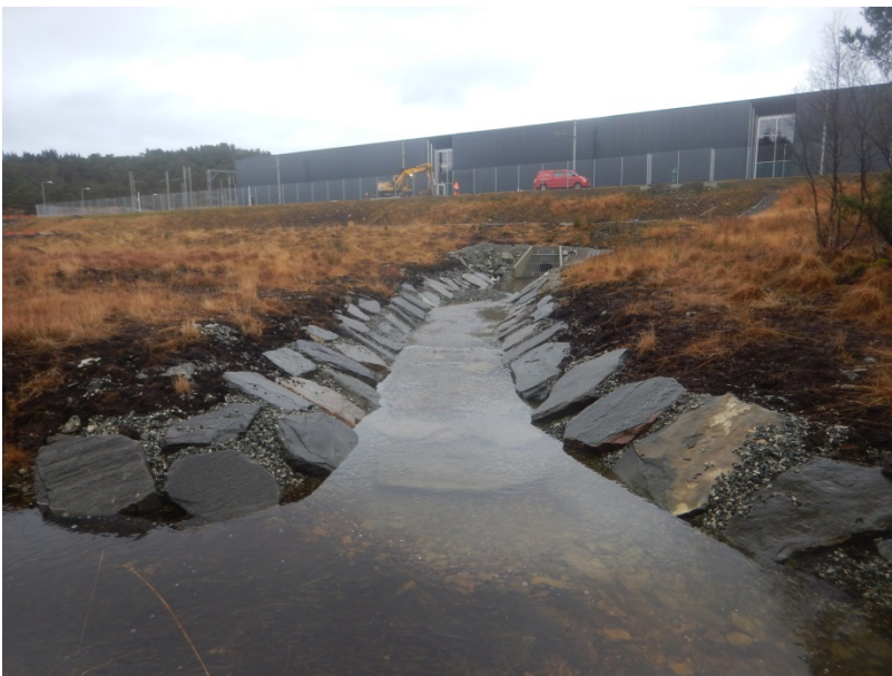
Figur 11. Plastret flomløp/dreneringskanal nedstrøms ny garasje for bybanen. Denne renner ut i Store Veitabekken (øvre del av Fleslandsvassdraget). Nedstrøms kanalen er grusen noe tett med finmasser. Foto: E.Olsen.
