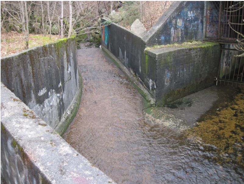
Figur 20. Kanalisert stryk i Sælenvassdraget: Morfologi – 1, substrat – 1, vegetasjon – 1. Foto: U.Pulg.
