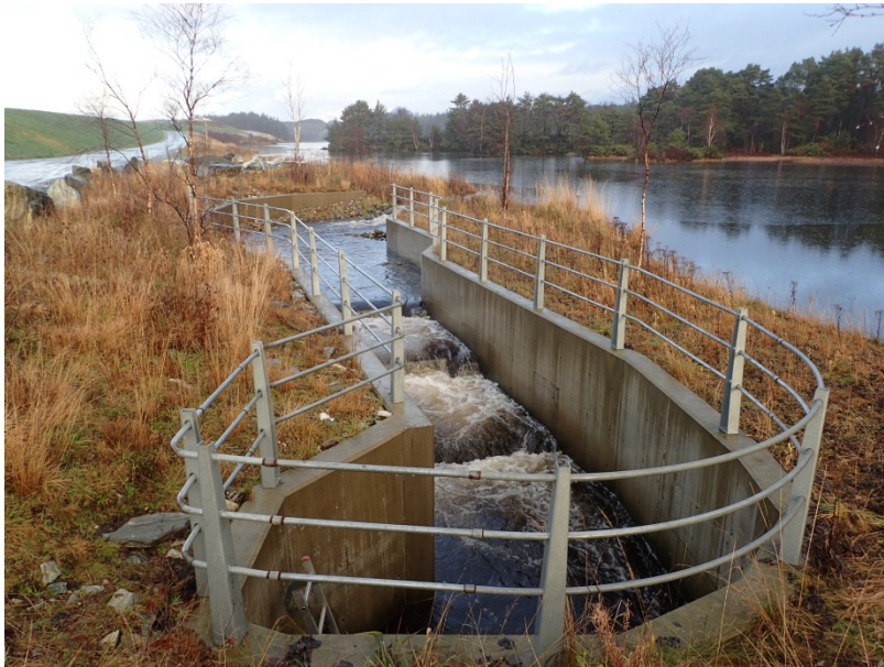
Figur 5. Utløpet fra Langavatn er utformet som fisketrapp. Denne renner ut i Fleslandselven i kulvert under rullebanen. Foto: G.Velle.
