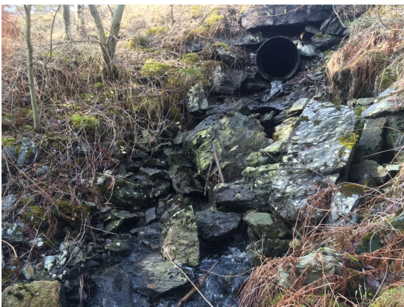
Figur 2. Innløpsbekk Grutlevatnet (merka 1 Figur 1), nedanfor fv. 541. Utforming av kulvert under fv. 541 hindrar fri vandrings av fisk. Bekken ovanfor kulvert er likevel ikkje viktig for fisk, og manglar gytesubstrat. Foto G. Velle.
