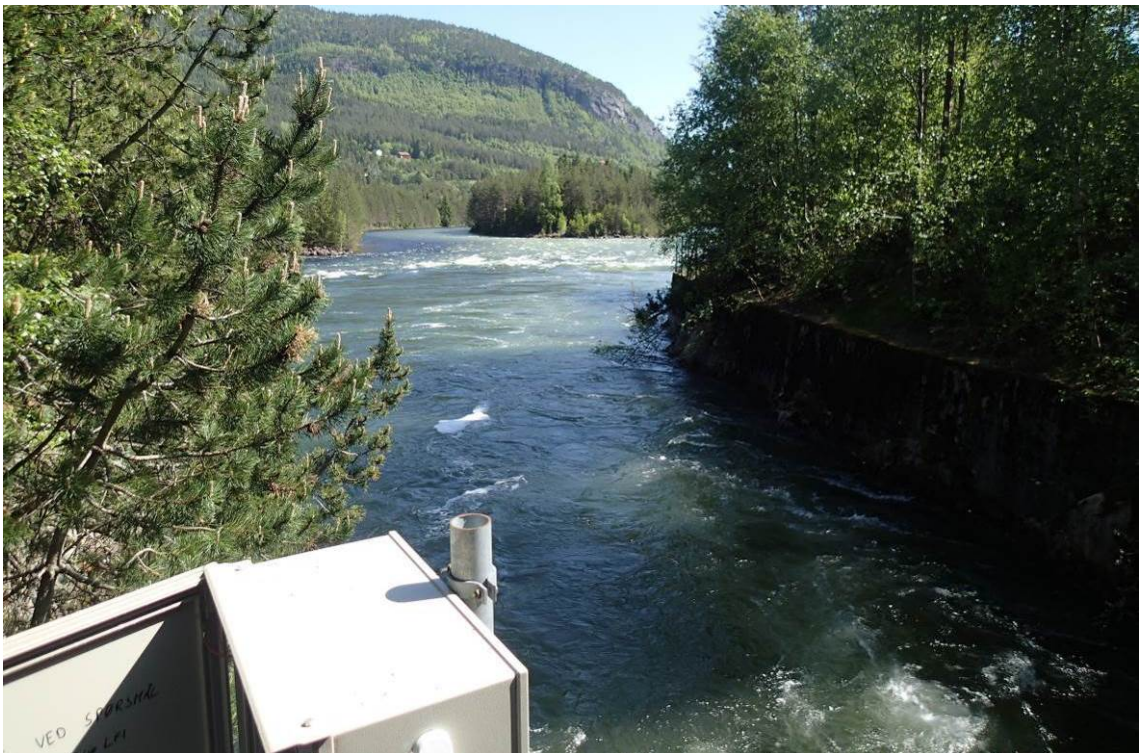
Fig. 19 Gassovermettet vann (blakket hvit, 166 % TGP) i utløp Brokke kraftverk (28.5. 2014)
