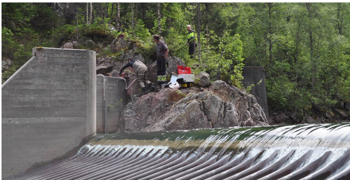
Fig. 2 Installasjon vannstandslogger og oppmåling juli 2014 (her Ljoså)
