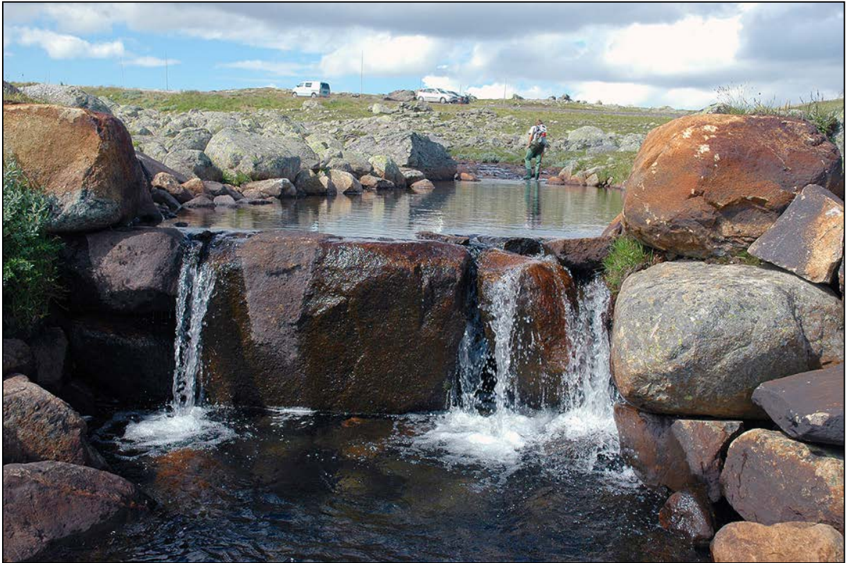
Figur 21: Vandringshinder for ørekyt, utformet som terskel med loddrett fall. Halnebekken.
