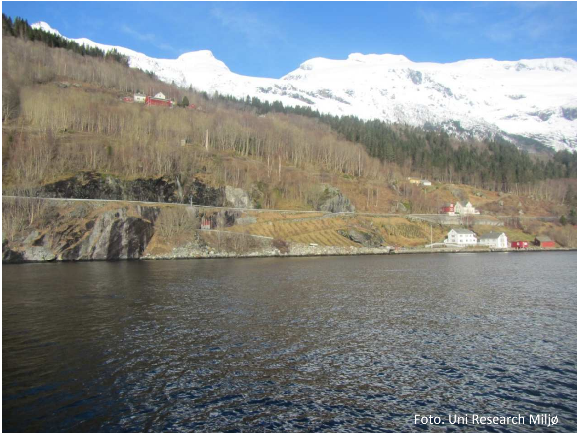
Stasjon ved Rogdaberg
