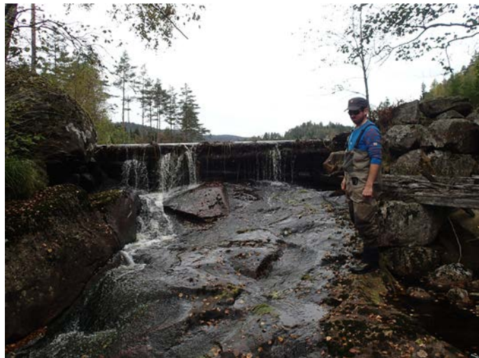
Bjelketerskel er et menneskeskapt vandringshinder.
