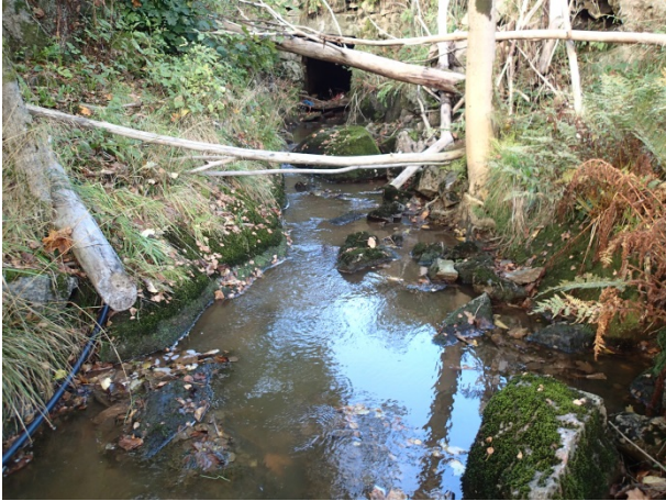
Utløpet med kulp-stryk variasjoner og gode skjulmuligheter for fisk. Kulverter er i flukt med elvebunnen og er ikke vandringshinder.
