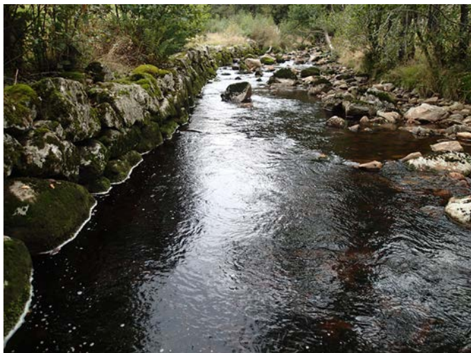
Forbygning langs den ene siden med skjulmuligheter for ungfisk. Forbygningen fungerer bra.
