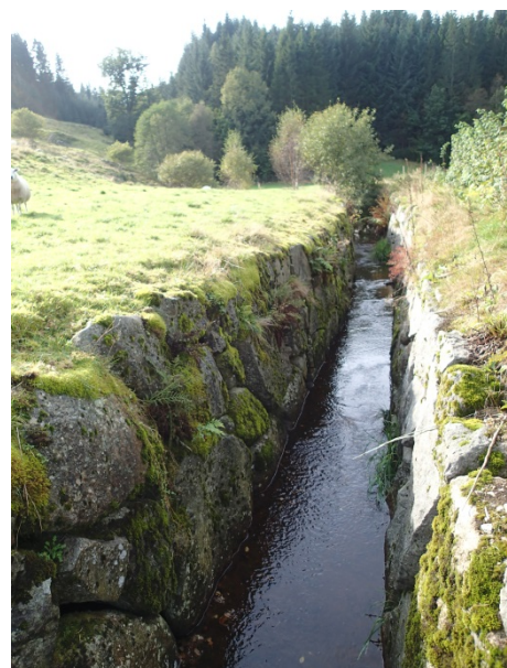
Bekken er sterkt kanalisert langsmed dyrka mark.
