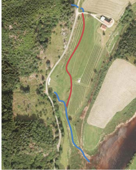
Rød linje angir bekkelukking av Holmeslandbekken. Bekkelukkingen er ca. 300 meter.
