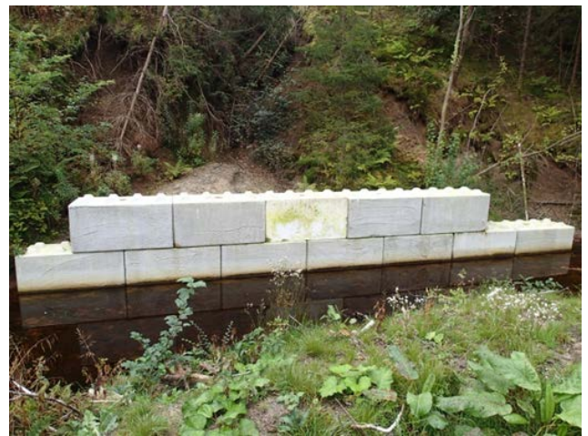
Forbygning for å hindre ytterligere erosjonsskade og sikre drivhus i midtre deler av bekken.
