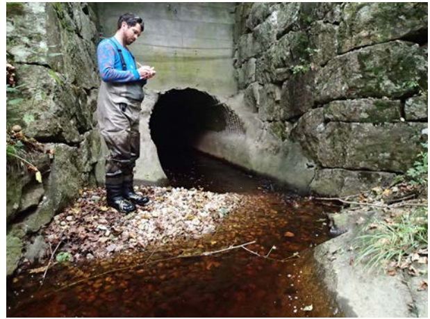
Egnet gytegrus var dumpet flere steder i en haug ned i bekken. Denne grusen må planeres ut.
