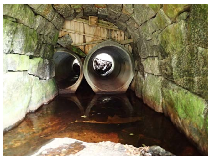
Kulverter oppstrøms foss vanskeliggjør videre vandring ved lav vannføring rett oppstrøms fossen.
