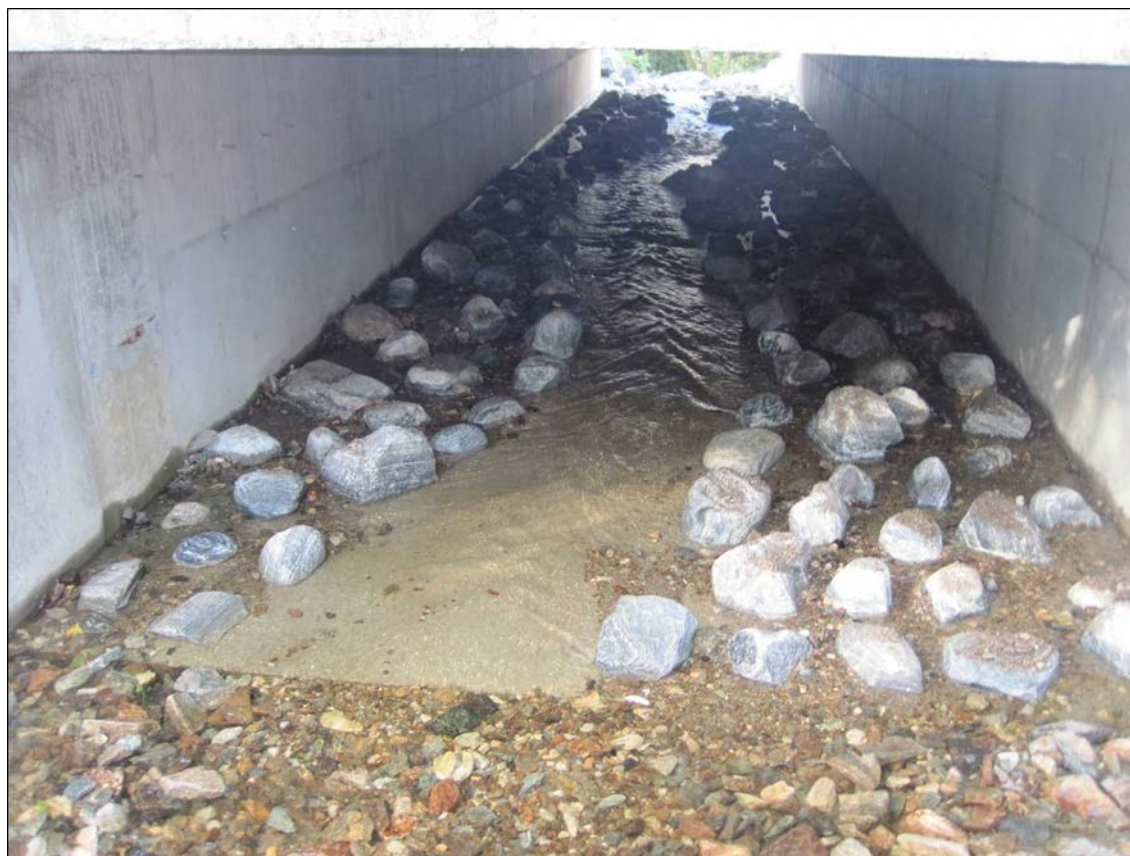
Figur 10. Bildet viser ny kulvert etablert i Apeltunvassdraget som ble sanert av Bergen kommune og som nå er passerbar for fisk igjen. Dette er et eksempel på et enkelt tiltak i kulvert med betongbunn. Etablering av strukturer, i dette tilfelle som steiner og dypvannsrenne, kan være nok for å sikre vandringsveien for fisk. Andre strukturer kan være ledebuner og terskler med lavvannsrenne.
