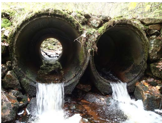
To hengende kulverter bør senkes.
