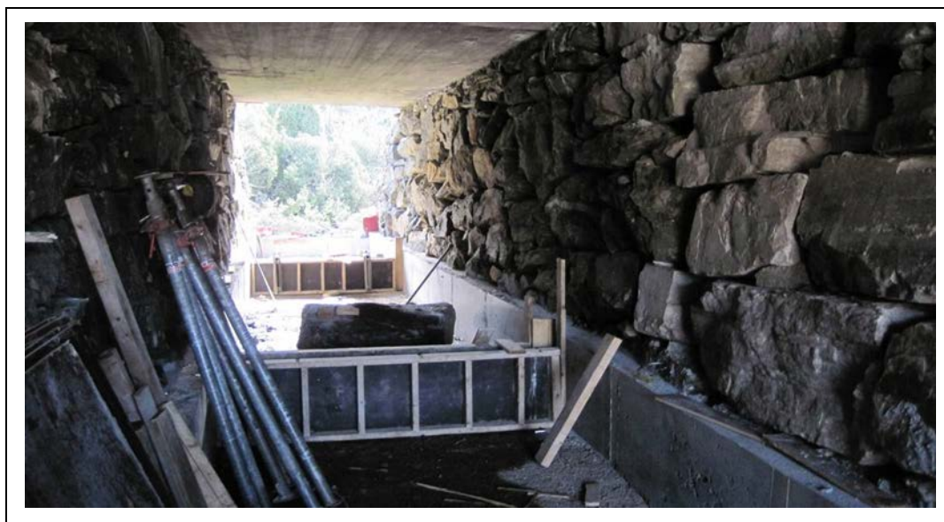
Figur 8. Bildet fra bygging av ny veikulvert ved en bekk i Sotra, Hordaland våren 2010. Her støpes det tverrvegger for å lette oppvandringen for fisk.
