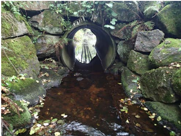
Dykket kulvert der elvebunnen og bunnen i kulvert flukter er en god løsning som sikrer vandringen av store og små fisk ved alle vannføringsforhold.
