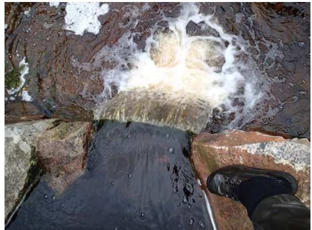
Spalteåpningene var for brede og bør være smalere og dypere.
