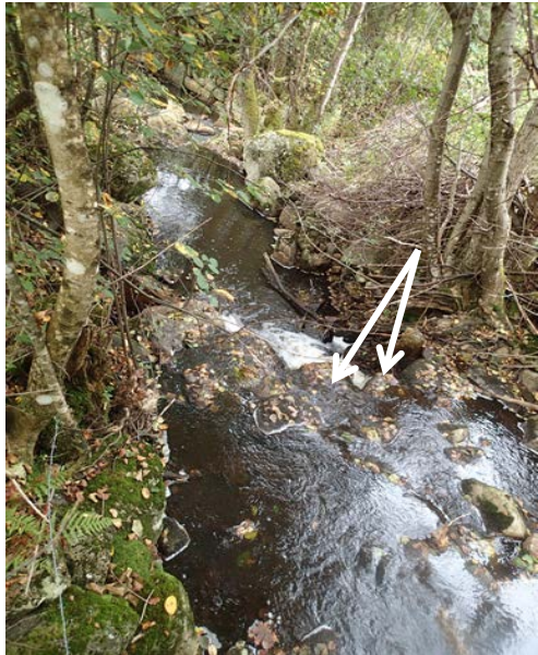
En eller to blokker bør plukkes ut for å danne lavvannsrenne i terskelen.
