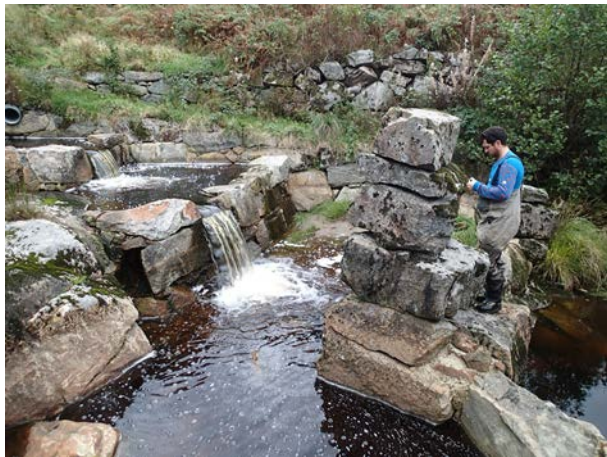
Hoppehøydene mellom kulpene i trappene var noe for høye for sjøaure, men kulpene var fine.
