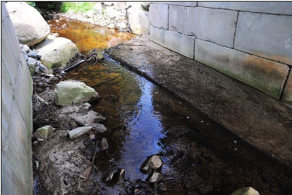
Bilde 4: Kulvert under vei inn mot sandtak. Delvis naturlig bunnsstrat, og ikke vandringshinder (VP 021).
