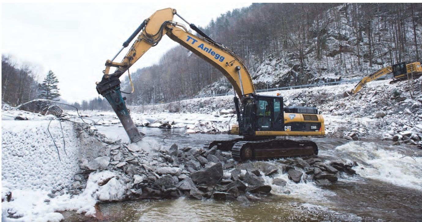
Fig. 14 Fjerning av terskler i Mandalselva 2016. Miljødesign-prosjektet er blant Norges mest omfattende og gjennomføres av Agder Energi sammen med Nina, Sintef, Uni Research Miljø LFI m.fl. Foto: Agder Energi.
