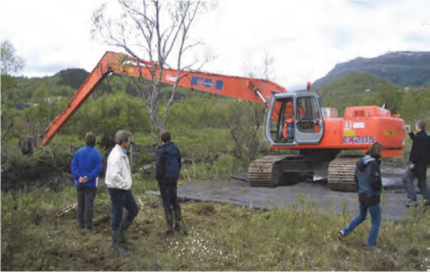
Fig. 115 Fjerning av vannvegetasjon og slam ved bruk av gravemaskin («Langemann») på flåte til venstre og på Forsvarets belastningsmatter til høyre for å unngå skader i våtmarksområder (foto NVE Region Nord).
