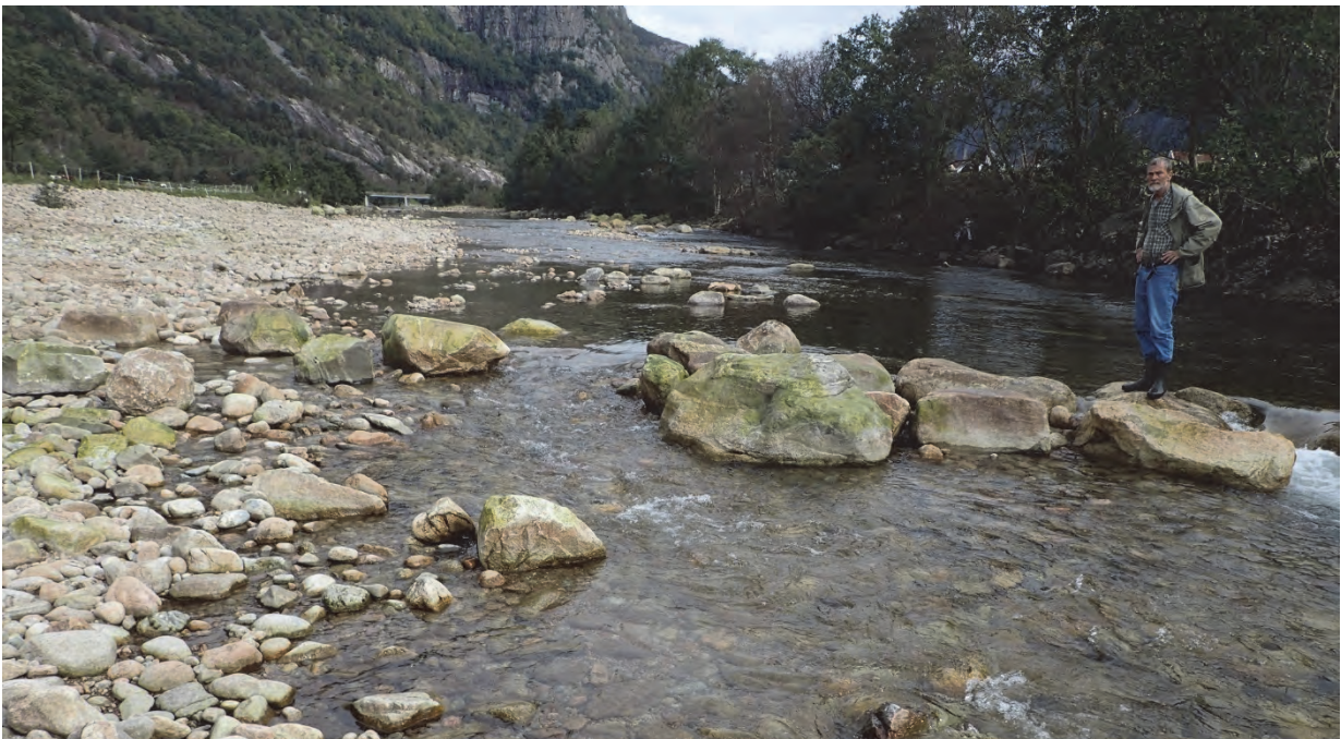
Fig. 80 Stein ble lagt ut enkeltvis og i grupper slik at de samlet danner buner gjennom enkeltsteinens oppstuingseffekt. Dimensjonering ble valgt for middel vannføring til ca. årsflom. Ved lav vannføring virker steinene knapt oppstuende og låser ikke elvebunnen. Massetransport og sedimentdynamikk finnes fortsatt.
