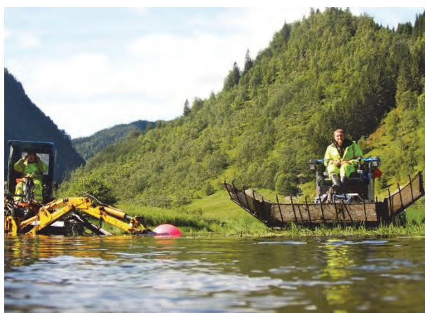
Fig. 60 Fjerning av krypsiv i Teigdalselva (venstre) ved hjelp av gravemaskin og spesialbygd fartøy. Finere sedimenter akkumuleres i og rundt ny tilvekst av krypsiv i Matreelven (høyre).
