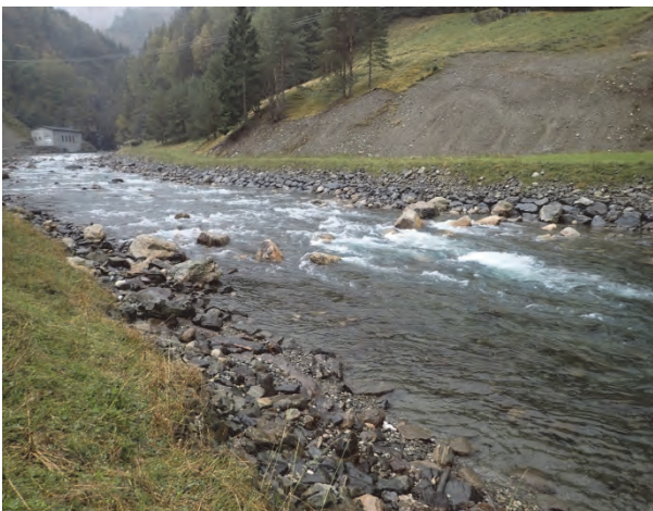
Istedenfor syvdeterskel: Buner av enkeltstein i Flåmselva 2017. Venstre bilde er tatt ved 9,5 \text{ m}^3/\text{s} . Steinene bidrar til økt vandekt areal men virker knapt hydraulisk. Ved 43 \text{ m}^3/\text{s} (høyre bilde) bremser steinene vannet langs bredden, virker hydraulisk og hever vannspeilet ovenfor. I midten av elven oppstår en ønsket, sterk strøm som bidrar å opprettholde kulp og brekk nedenfor. Ved breiddfull vannføring er steinene 2 m under vann og virker knapt hydraulisk.
