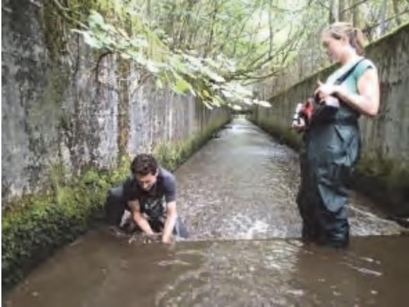
Fig. 74 Venstre: Montering av bunnelementer i en betongkanal som var vandringshindrende ved lav og middels vannføring. Høyre: Fra bygging av fisketrappen ved Osbanekulverten (hybridtrapp).
