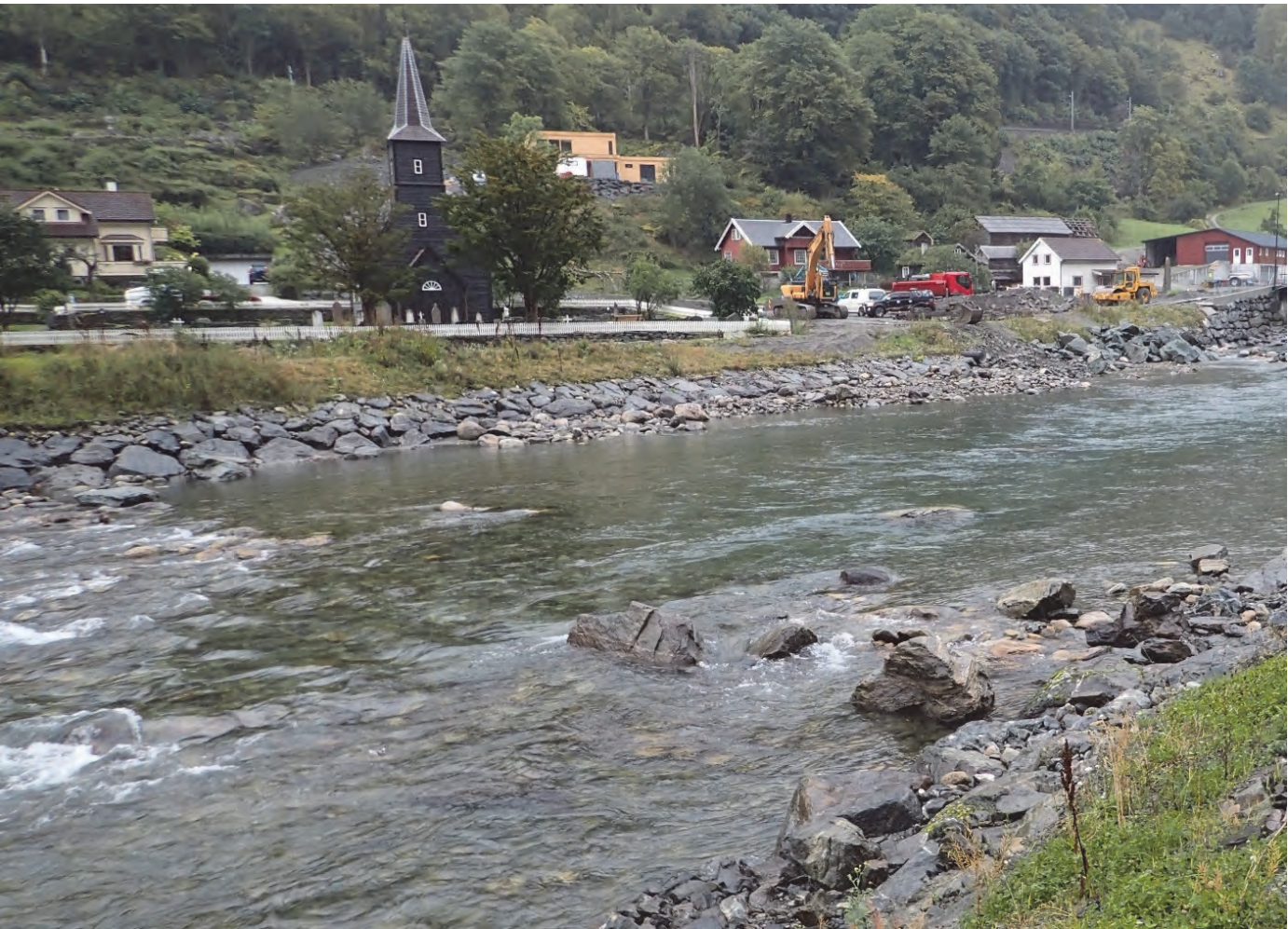
Bunnstabilisering som reduserer erosjonsrisiko langs elvebreddene ovenfor. Tiltaket er utformet som et naturlig brekk bygget opp av enkelte steinblokker. Det virker moderat oppstuende ved lav vannføring siden det både er en lavvannsrenne og vann kan renne mellom steinene. Bevegelse av enkeltstein tolereres.
