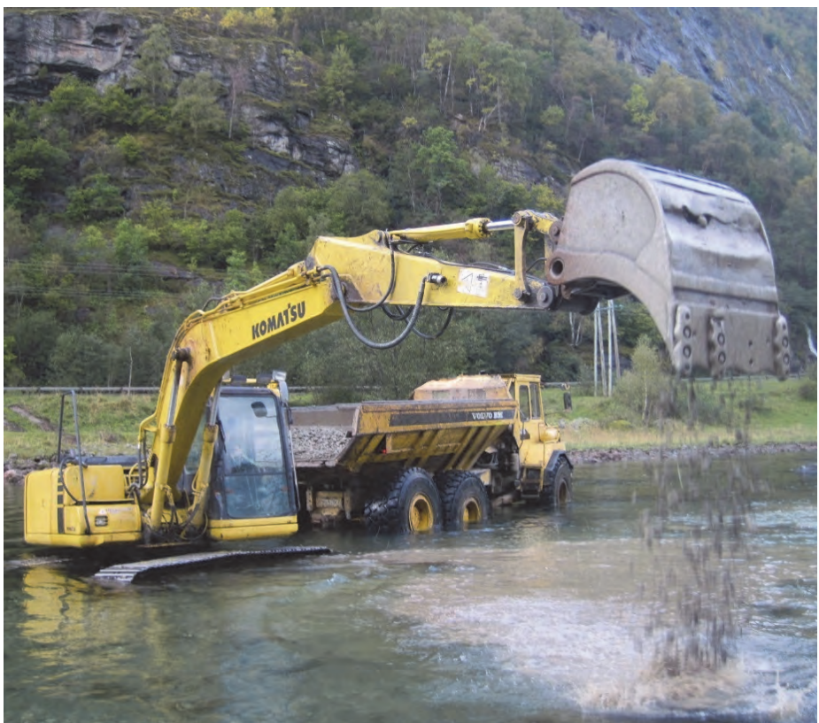
Grusutlegg med helikopter i Nidelva (Foto til venstre: Agder Energi), og med gravemaskin og dumper i Aurlandselva (Agder Energi, E-Co Energi og Uni Research Miljø LFI).
