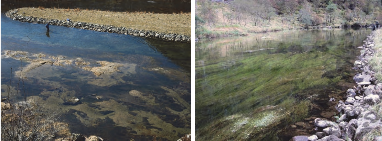
Fig. 61 Bildet til venstre (tatt 2006) viser tiltaksområdet i Matreelven der det ble fjernet krypsiv, laget en ledebune og lagt ut gytesubstrat. Bildet til høyre (tatt 2012) viser at deler av området er gjengrodd.
