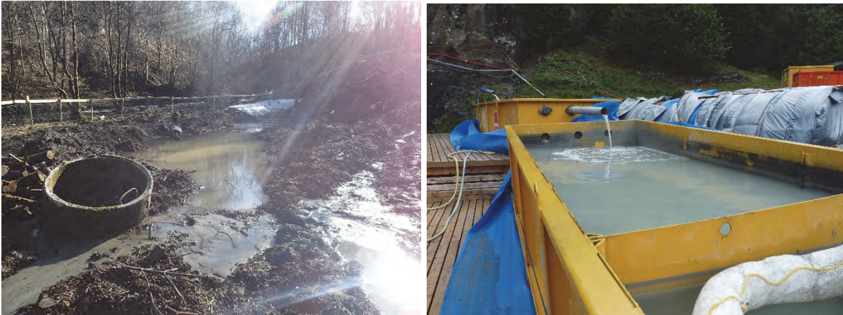
Fig. 59 Tiltak mot finsedimentutslipp fra anleggsområder: Venstre bilde viser en voll ved Apeltunelven som dannet et stort avsetningsbasseng for overvann fra et anleggsområde. Vann fra tunneldriving ble ledet direkte til kommunalt avløpsnett, slik at denne urbane sjørretelven kunne skjermes mot forurensing. Høyre bilde viser et mobilt renseanlegg for tunneldrivingsvann i bruk for Statens Veivesen ved Granvinsvassdraget.
