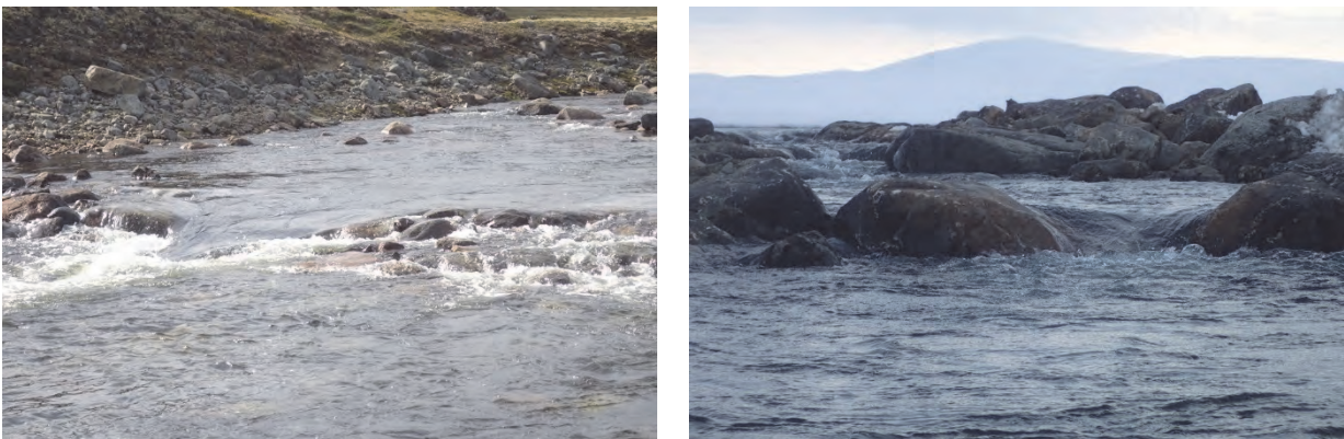
Fig. 27 Detaljer fra lavvannsrennen i Djupa. Den er utformet som trinn-kulp -type med spalteformete overløp, til venstre ca. ved medianvannføring, til høyre ved lavvannføring om vinteren. Vandringsmuligheter for fisk finnes ved alle vannføringer.
