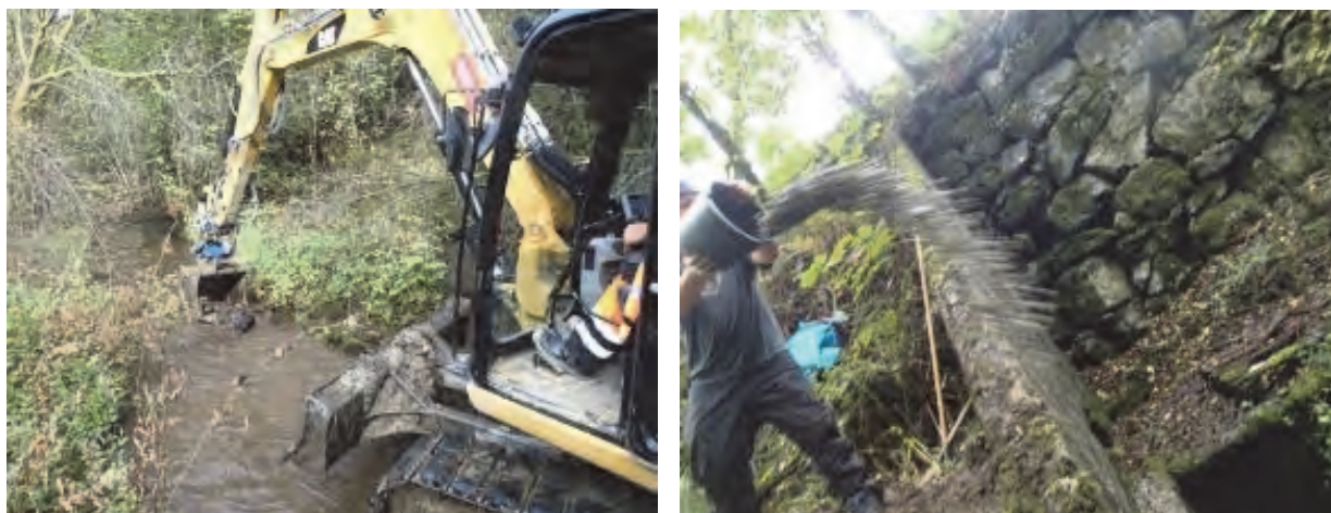
Fig. 75 Harving med gravemaskin og tilførsel av gytegrus har bedret habitatforholdene for sjørret
