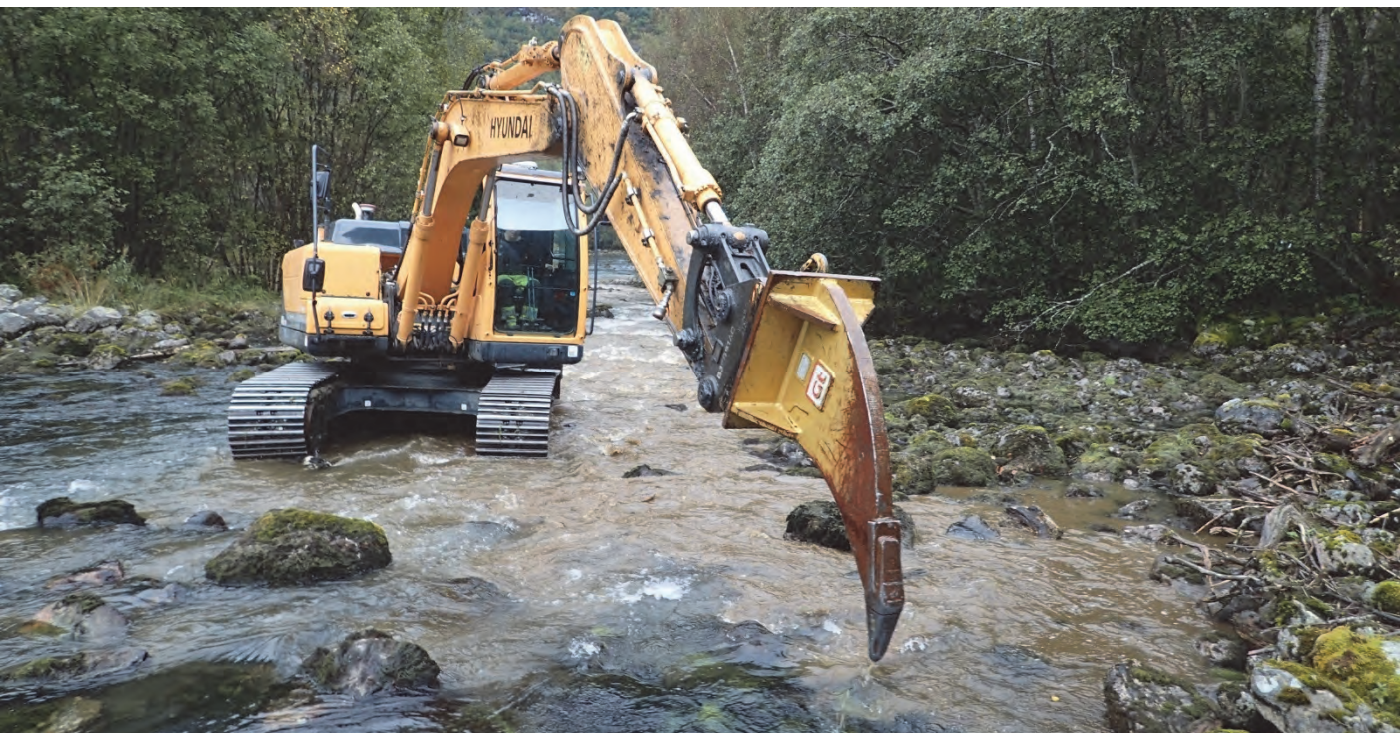
Ripper i aksjon.
