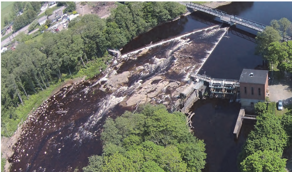
Naturtypisk omløp ved Herting kraftverk i Atran (Sverige, se også nærmere beskrivelse i kap. 7). Omløpet har minst 11 m 3 /s og brukes både til opp og nedvandring av fisk. (Foto: Fiskevårdsteknik AB)
