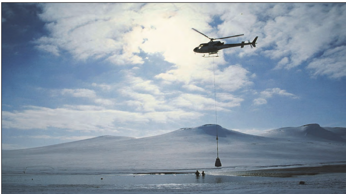
Fig. 91 Utlegging av gytegrus i Bjornesfjorden i ved bruk av helikopter. Grusen var i forkant sortert til spesifisert kornfordeling, pakket i storekk og transportert inn til Bjornesfjorden med beltevogner.
