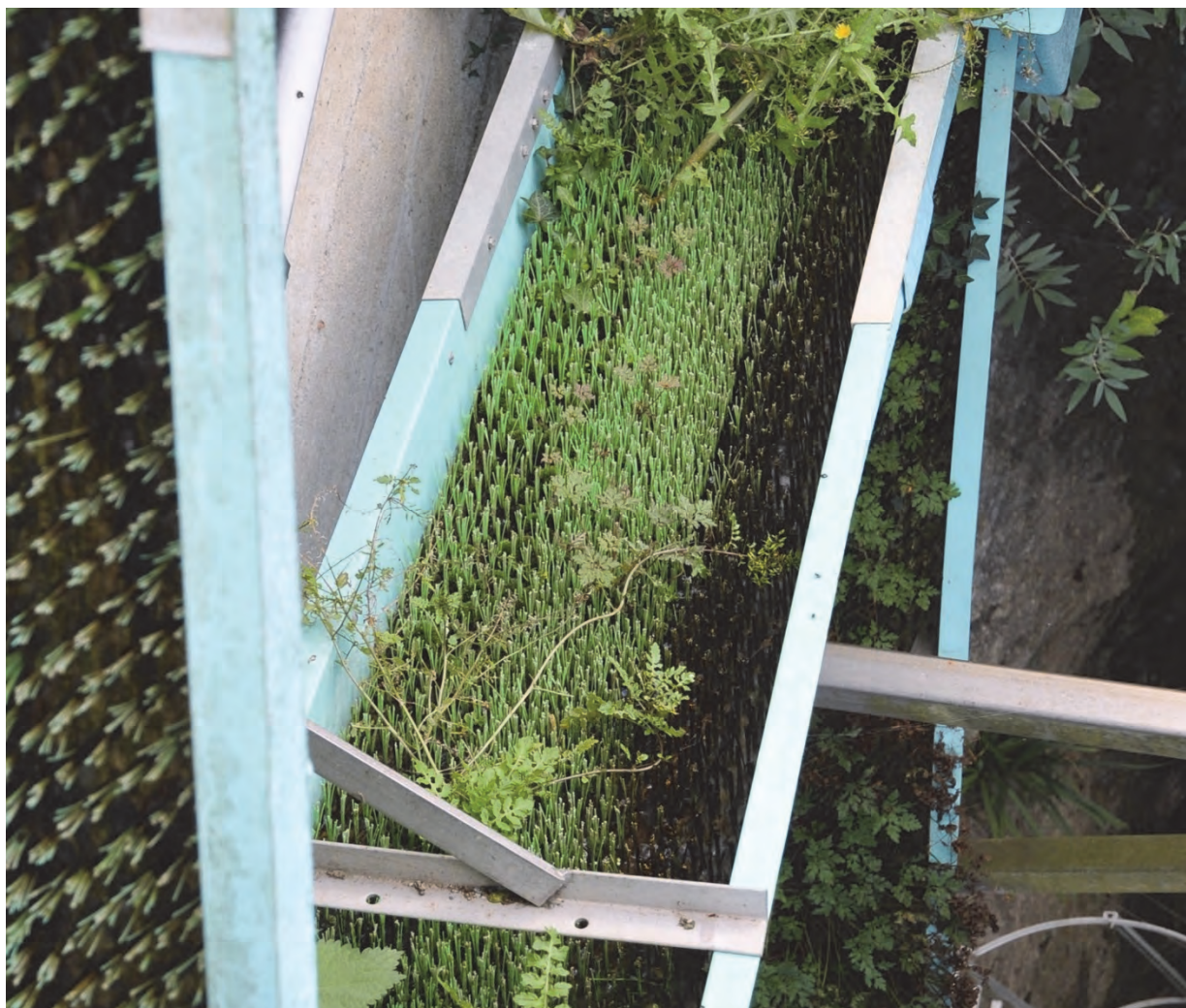
Fig. 40 Ålepassasje ved kraftverk i Frankrike. Her ledes oppvandrende glassål til en rampe fylt med «kunstgress» og vann. Denne og lignende metoder er benyttet ved mange kraftverk i Frankrike, Tyskland, Irland og England. (Foto: Frode Kroglund).
