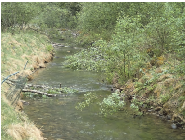
Fig. 53 Trær utlagt og festet i Tokvamsbekken, et sideløp i Aurlandselva.
