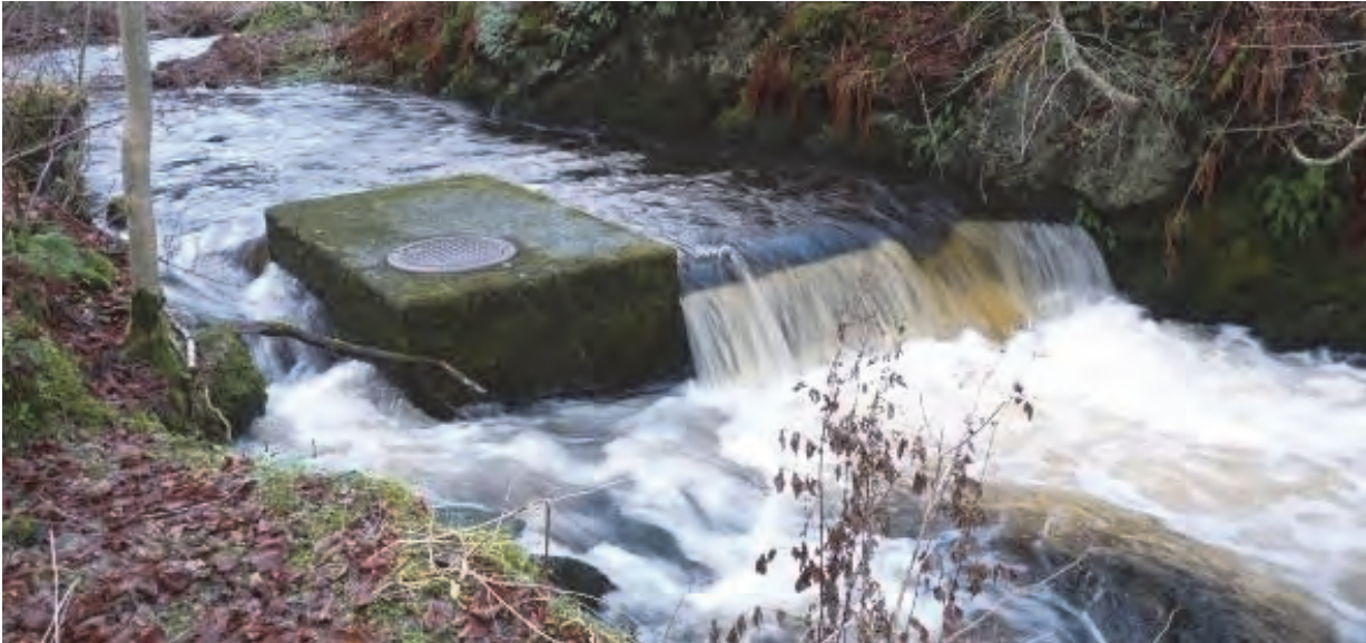
Fig. 36 Eksempel på et lite omløp ved terskel med vanninntak i Apeltunelva i Bergen. Sideløpet til venstre for vanninntaket ble åpnet og sikret med stein. Fisk kan nå vandre fritt ved de fleste vannføringer. Tidligere kunne fisk bare passere ved større flommer (vannføringsavhengig vandringshinder). Sideløpet ble lagt slik at vanninntaket fortsatt fungerer etter hensikten (bidrag til sirkulering av brakkvannspoll). Kostnader 4 timer dugnad (Bergen Sportsfiskere).
