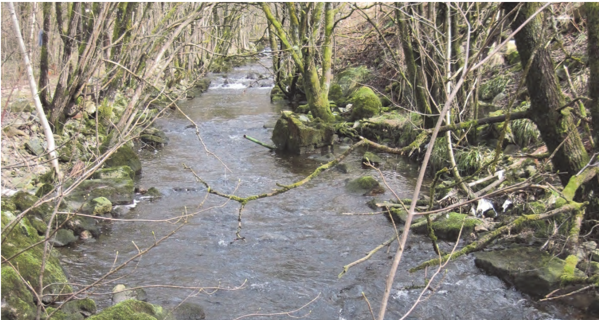
Fig. 67 Denne erosjonssikringen med uregelmessig steinutlegg («steinrøys») og trær i Sælenelven har tålt mange tiår med flommer, og har gitt langt bedre miljøforhold enn glatt plastring eller mur. Sedimentdynamikken er redusert, men det finnes fortsatt skjul, hulrom, røtter og trær langs elvekantene.
