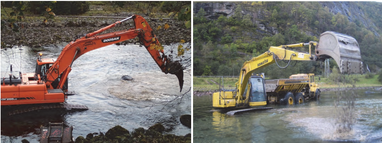
Fig. 132 Ripping (venstre) og utlegging av gytegrus (høyre)
