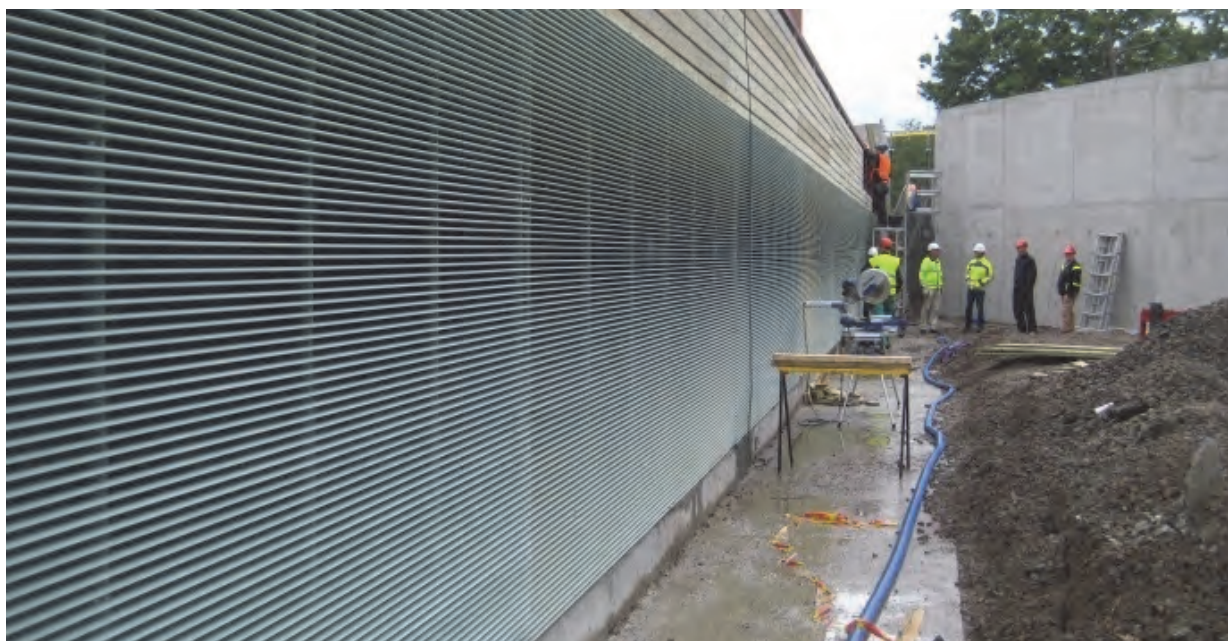
Fig. 44 \beta -varegrind med fluktåpning (bakgrunn) foran vanninntak ved kraftverk Herting. Varegrinden har horisontale spiler med 15 mm spaltevidde, automatisk ristrensning og vertikal fluktåpning som også brukes som spyleluke (Foto: Olle Calles).
