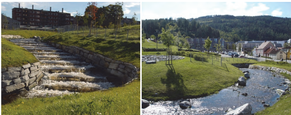
Fig. 109 Ilabekken etter gjenåpning med etablering av fisketerskler og gyteområder for sjøørret. Foto: Trondheim kommune.
