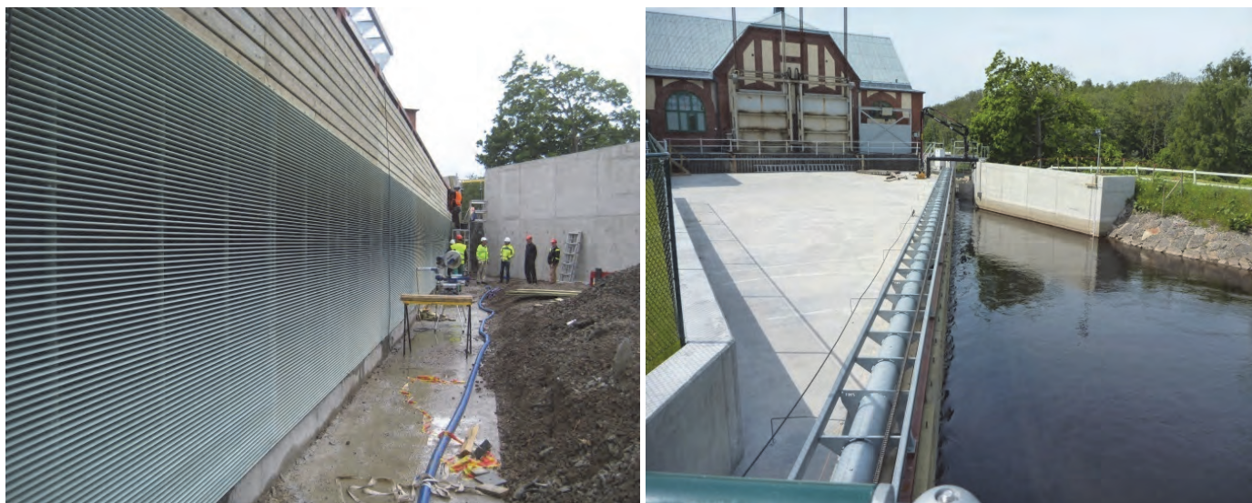
Fig. 141 \beta -varegrind med fluktåpning (bakgrunn) uten og med vann. Varegrinden har horisontale spiler med 15 mm spaltevidde, automatisk ristrensning og vertikal fluktåpning som også brukes som spyleluke (Foto: Olle Calles).
