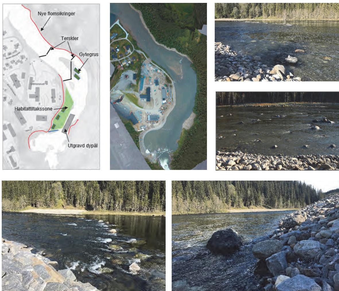
Fig. 130 «Sjøforsløpet» i Røssåga etter gjennomførte tiltak.
