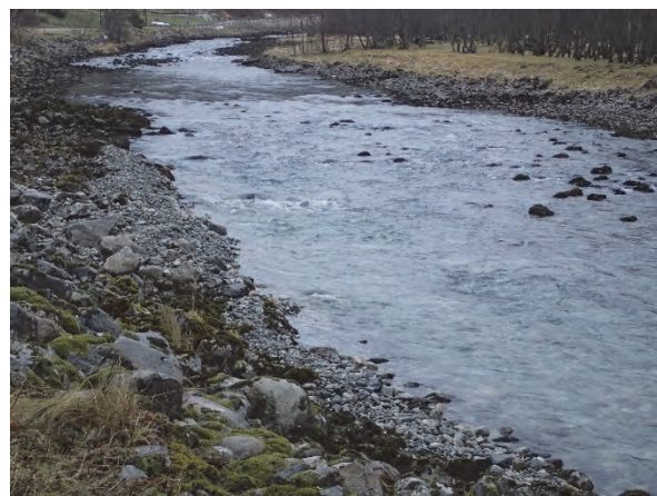
Fig. 57 100 m 3 grus og rullestein (32-200 mm) utlagt langs en erosjonssikret elvebredd i Aurlandselva (2016). Året etter (høyre bilde) var mesteparten av sedimentet erodert og fordelt nedstrøms utover elvebunnen, der det virker som gytesubstrat og ungfiskhabitat (E-Co Energi og Uni Research Miljø LFI).
