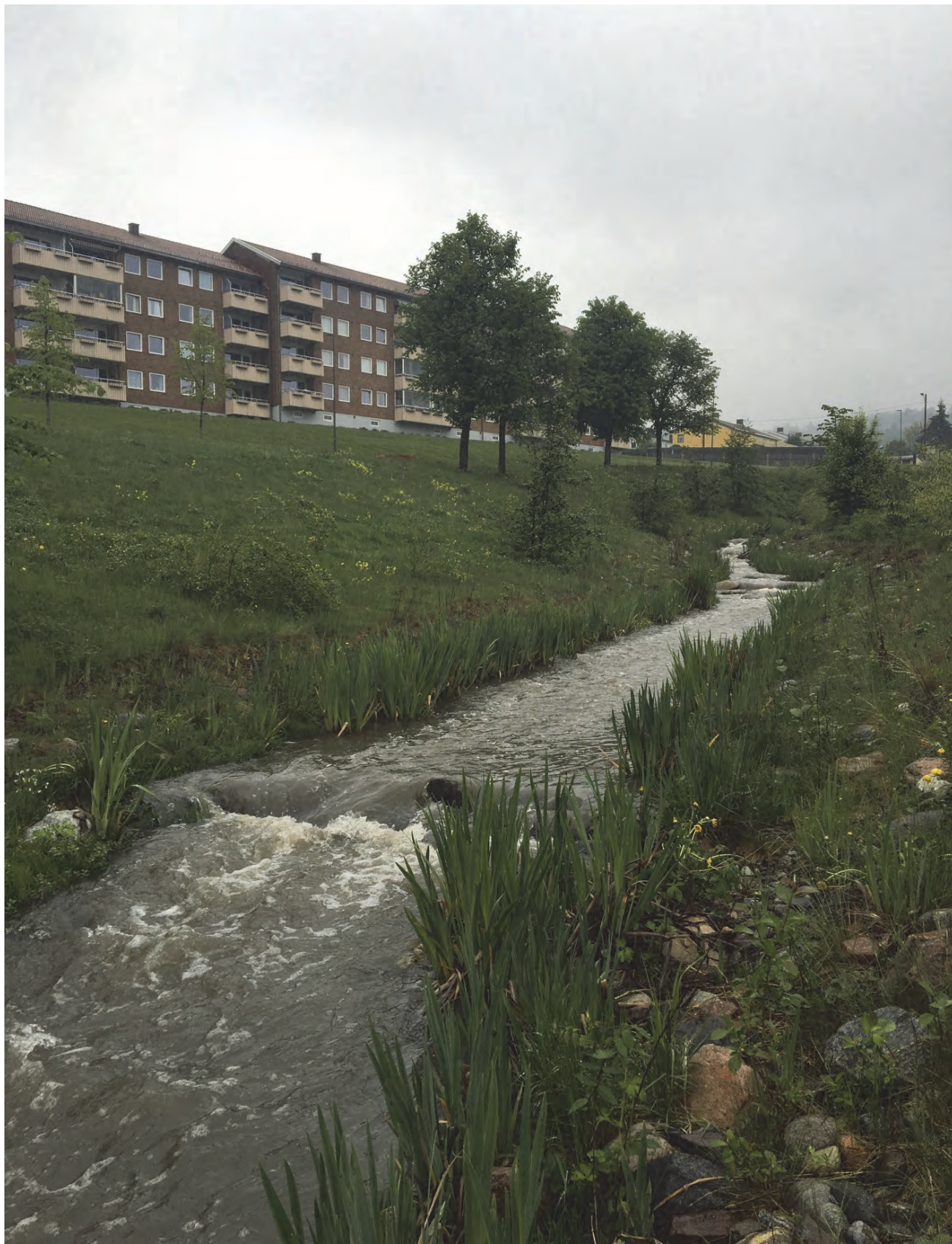
Hovinbekken i Oslo er gjenåpnet gjennom Bjerkedalen park over en strekning på 350 meter. Det er lagt til rette for vandring og opphold for ørret som naturlig hører til i vassdraget. Prosjektet har vunnet Oslo Bys Arkitekturpris i 2015 og pris for Norges beste uterom i 2016. Tiltakshaver Oslo kommune, med Dronninga landskap (bilde: Oslo kommune VAV, med tillatelse fra VAV/Tharan Fergus).
