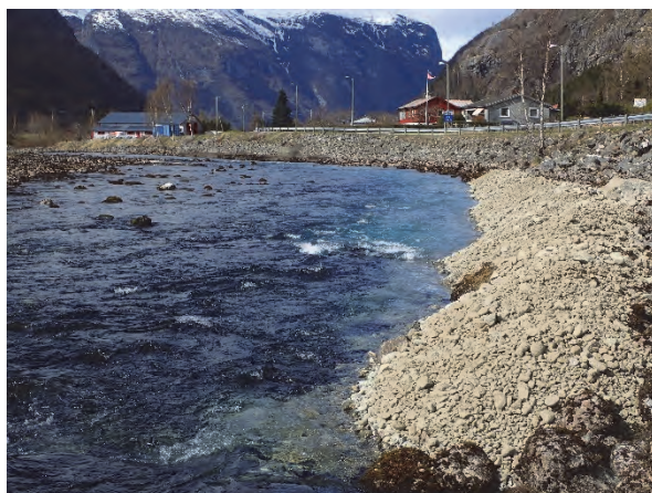
Fig. 57 100 m 3 grus og rullestein (32-200 mm) utlagt langs en erosjonssikret elvebredd i Aurlandselva (2016). Året etter (høyre bilde) var mesteparten av sedimentet erodert og fordelt nedstrøms utover elvebunnen, der det virker som gytesubstrat og ungfiskhabitat (E-Co Energi og Uni Research Miljø LFI).
