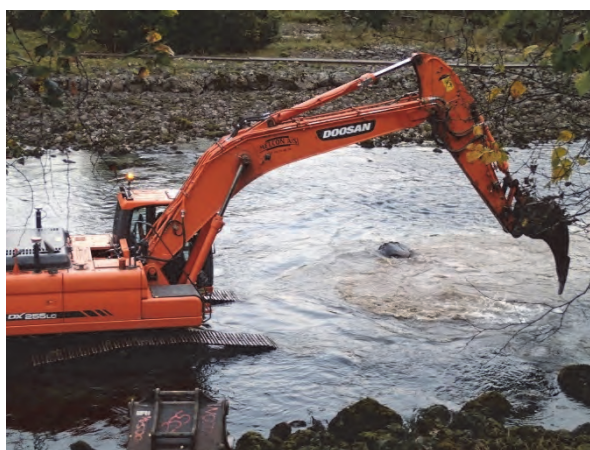
Fig. 55 Harving med ripper.
