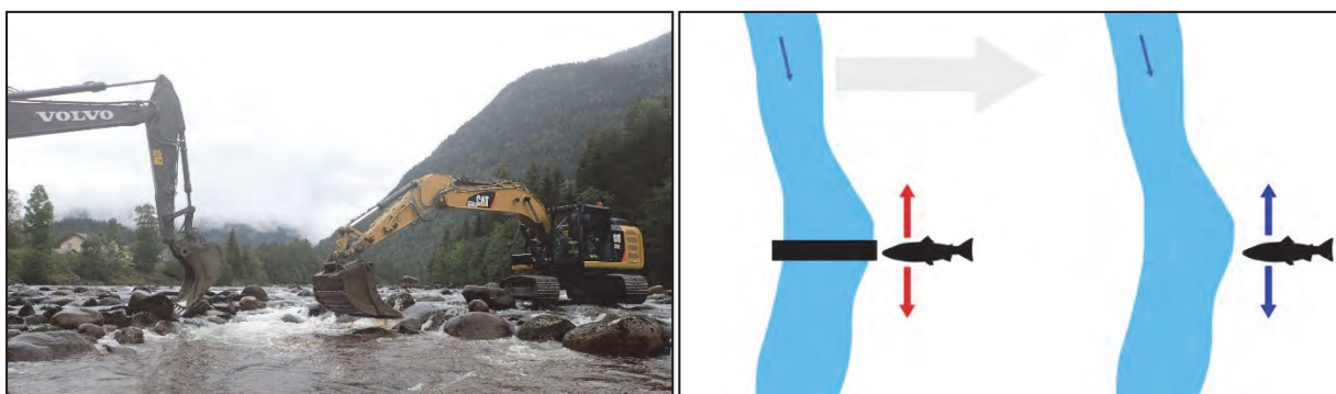
Fig. 22 Fjerning av kunstige vandringsbarrierer gir full konnektivitet for fisk og bunndyr. Bildet til høyre viser fjerning av terskler i Tokkeåni.
