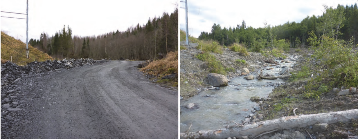
Fig. 122 Bildene er tatt på samme sted. Til venstre under anleggsarbeidet og til høyre like etter at arbeidet er ferdig. Trær og gressstuer ble plantet oppå vekstmassene.
