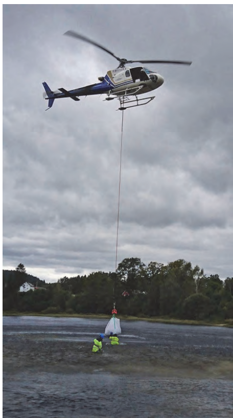
Grusutlegg med helikopter i Nidelva (Foto til venstre: Agder Energi), og med gravemaskin og dumper i Aurlandselva (Agder Energi, E-Co Energi og Uni Research Miljø LFI).
