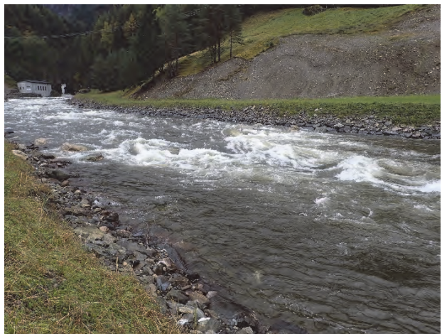
Istedenfor syvdeterskel: Buner av enkeltstein i Flåmselva 2017. Venstre bilde er tatt ved 9,5 \text{ m}^3/\text{s} . Steinene bidrar til økt vandekt areal men virker knapt hydraulisk. Ved 43 \text{ m}^3/\text{s} (høyre bilde) bremser steinene vannet langs bredden, virker hydraulisk og hever vannspeilet ovenfor. I midten av elven oppstår en ønsket, sterk strøm som bidrar å opprettholde kulp og brekk nedenfor. Ved breiddfull vannføring er steinene 2 m under vann og virker knapt hydraulisk.
