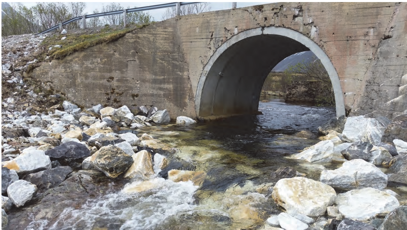
Fig. 31 Eksempel på passerbar terskel nedenfor veibro i Storelva ved Tromvik (med tillatelse fra Statens Veivesen, SVV rapport 459 «Frie fiskeveger»)
