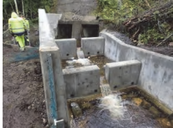
Fig. 74 Venstre: Montering av bunnelementer i en betongkanal som var vandringshindrende ved lav og middels vannføring. Høyre: Fra bygging av fisketrappen ved Osbanekulverten (hybridtrapp).
