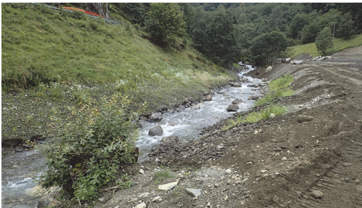
Fig. 66 Fra anleggsområdet Tverrelvi i Flåm 2016. Bekken ble fullstendig erosjonssikret med gjennomgående kant- og bunnplastring (se tegning ovenfor), noe som knapt er synlig. Plastringen er ru og uregelmessig, samt at den er satt ut til side og gravd ned i bakken. Med dette er det rom for naturtypiske elvebredder og substrat i bekken. Kantvegetasjon med stedegen selje og gråor er plantet.
