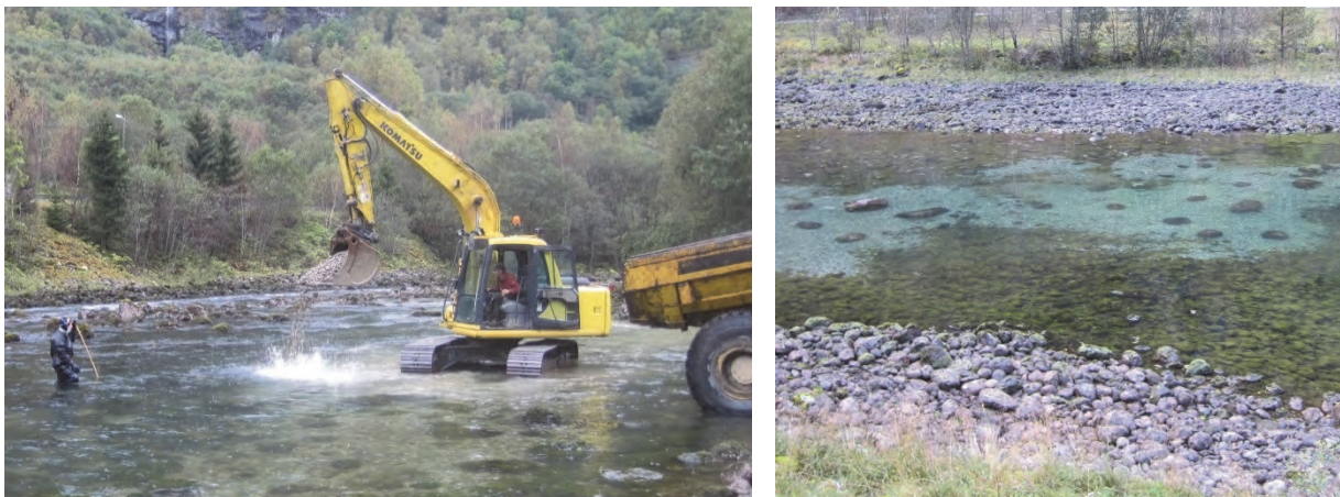
Fig. 50 Grusutlegg i Aurlandselven, 2013. En fiskebiolog følger med under og over vann, og anviser maskinfører. Ferdig gyteplass på bildet til høyre.
