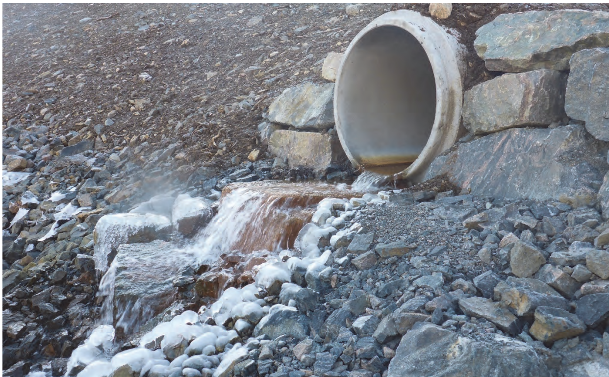
Fig. 7 Ny vandringsbarriere ved veikulvert bygget i 2016 ved munning av anadrom sjørretbekk ved Arefjordpollen, Hordaland.
