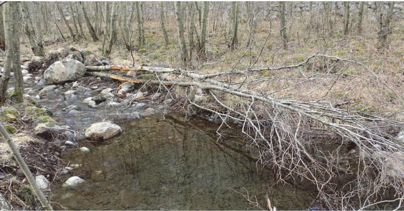
Døde trær som er festet med steinblokker i restaurert sideløp til Vassbygdelva i Aurland 2017. (E-Co energi med Uni Research Miljø LFI)
