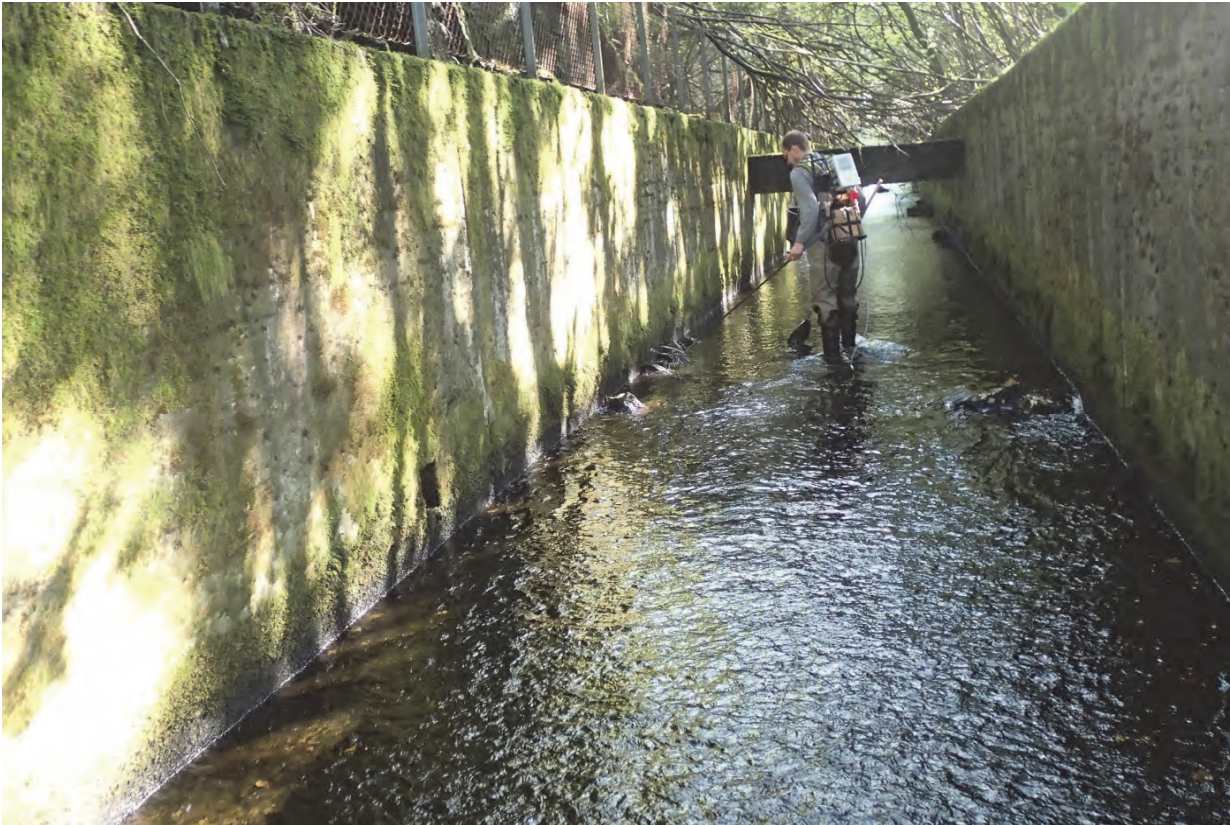
Fig. 62 Det er lite fisk på elvestrekninger som har blitt erosjonssikret med plastring eller betong fra alle kanter. Slike lokaliteter mangler skjul, variasjon, gytegrus og tilgang til hulrom i elvebunnen. Strømhastigheten er stor ved flom, og tilførselen av gytegrus og rullestein fra elvebredden er blokkert.
