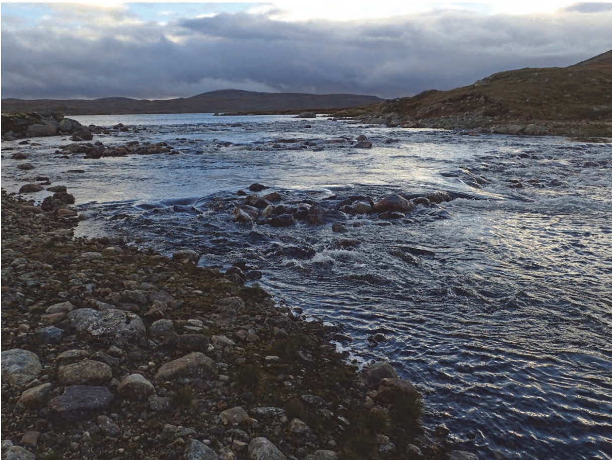
Fig. 23 Djupa, utløp fra Langesjøen på Hardangervidda 2015. En geometrisk terskel fra 1960-tallet ble ombygget til et naturtypisk stryk buner og lavvannsrenne. Høydeforskjell 2 m. (Statkraft, Uni Miljø LFI)
