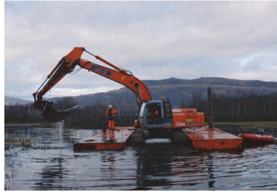
Fig. 115 Fjerning av vannvegetasjon og slam ved bruk av gravemaskin («Langemann») på flåte til venstre og på Forsvarets belastningsmatter til høyre for å unngå skader i våtmarksområder (foto NVE Region Nord).
