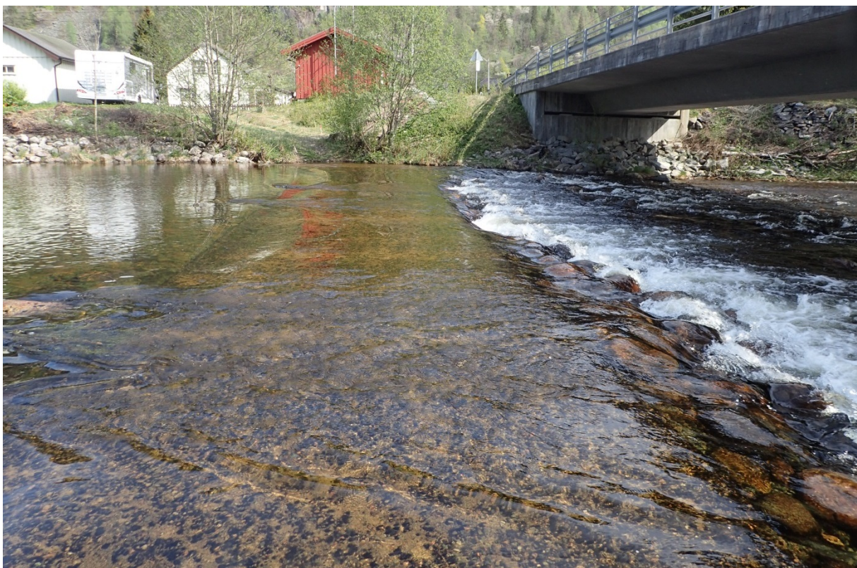
Figur 7: Betongterskel i løp ved Buøy med bredt og grunt overløp.
