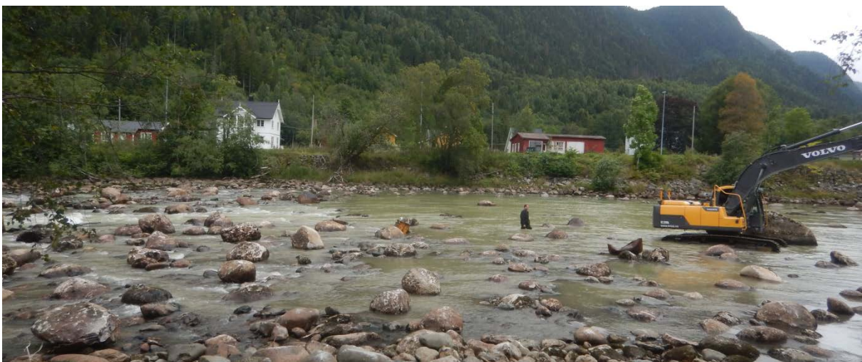
Figur 12: Bildet viser arbeidet med senkning av terskel, ripping og grusutlegg i 2016.
