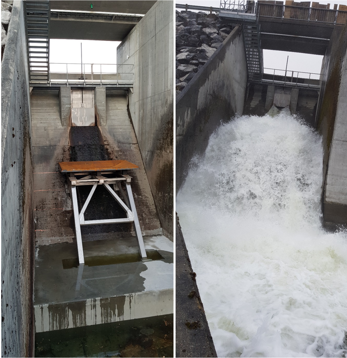
Figur 9 Deflektoren etter installasjon i dam Tjurrmo, med og uten vann. Første testkjøringer indikerer en reduksjon av gassovermetning med 63-75 %.
