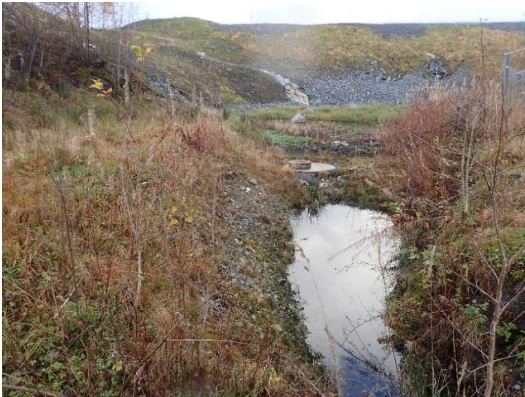
Figur 16. Øvre del av Lønningsbekken. Lønningtjernet er fylt igjen med masser
