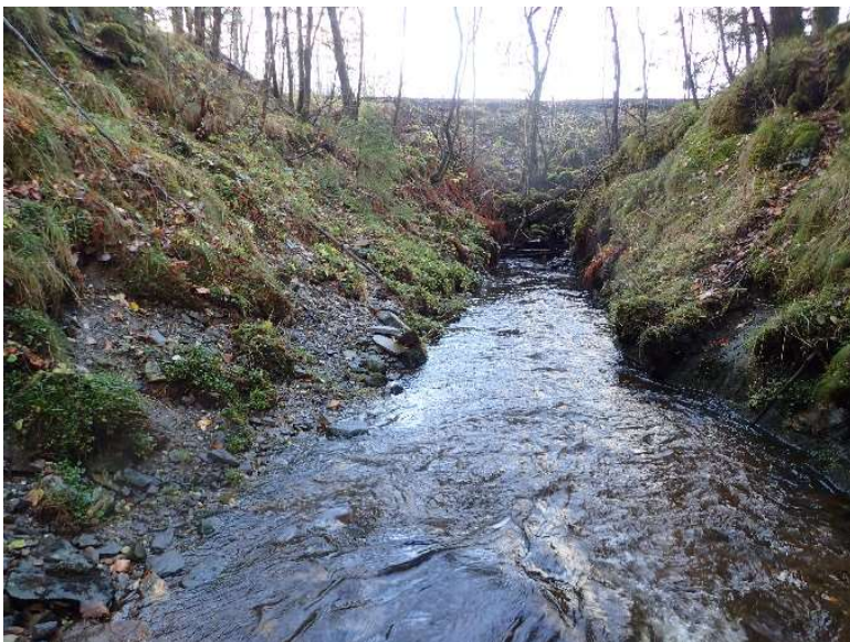
Store Veitabekken rett før kulvert inn mot flyplassområdet.
