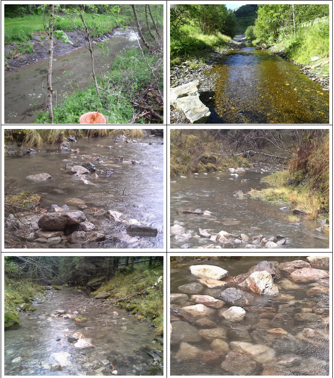
Bilde 13. Øverst: Strekingen i øvre del av restfeltet i Vikja var påvirket av silt og bar preg av å være homogen, også etter utlegging av enkelte blokker. Midten og nederst: Blokker og steiner ble plassert på elvebunnen og noen trær ble rotveltet for å øke skjulmulighetene for ungfisk. Tiltaket har muliggjort utplantning av lakserogn i etterkant og vil trolig være et godt ungfiskhabitat i årene som kommer.
