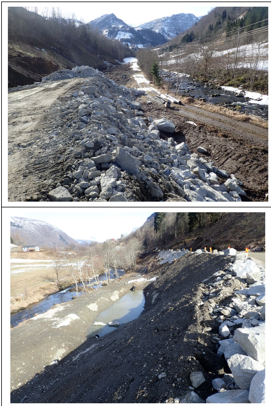
Statens Vegvesen sitt massedeponi på Hesjasletta som er ferdigstilt 2019.
