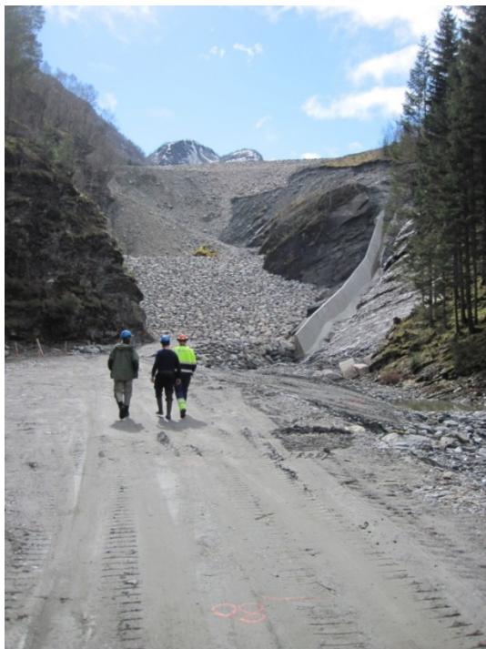
Bilde 9. Restaurering av Refsdal dam.
