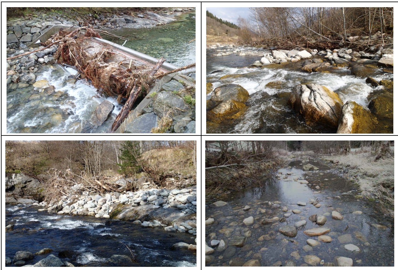
Bilde 15. En stor flom i oktober 2014 endevendte store strekninger av elvebunnen i restfeltet. Smoltfellen ble skadet og flomvannet etterlot seg store mengder masser både i forkant og bakkant av fellen. Bunnsstrat fra elva ligger på land flere steder.
