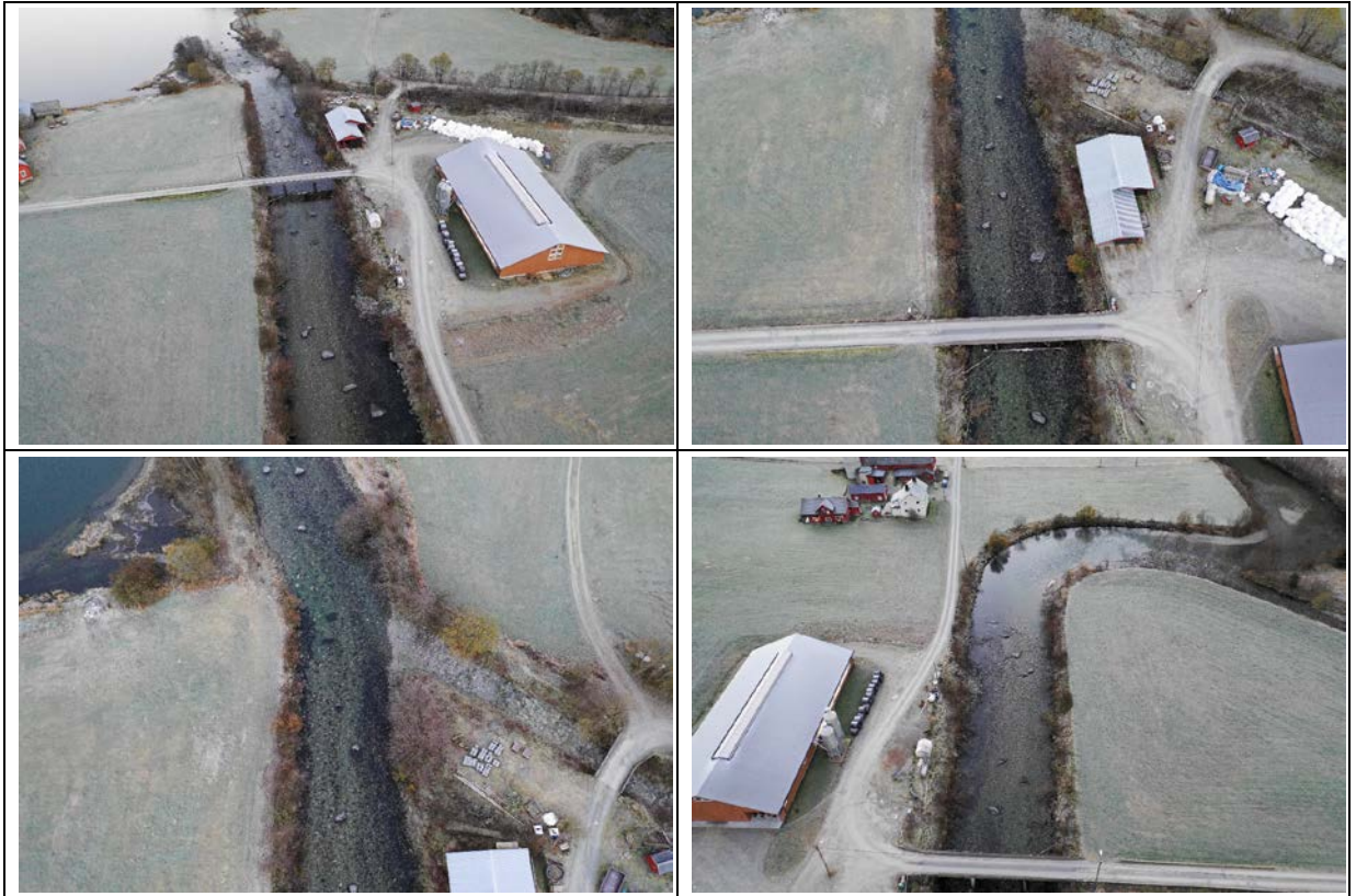
Figur 61. Steinutlegg i nedre del av Hopssselva ved utløp til Hopsvatnet.
