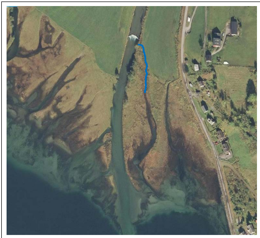
Figur 19. Sideløp i elvedeltaet ble gjenåpnet ved å lage en åpning i forbygningen i hovedelven rett nedstrøms terskelen og ved å grave ut en nytt løp i øvre del av sideløpet. Det ble lagt ut blokker i sideløpet for å skape bedre leveområder for ungfisk.
