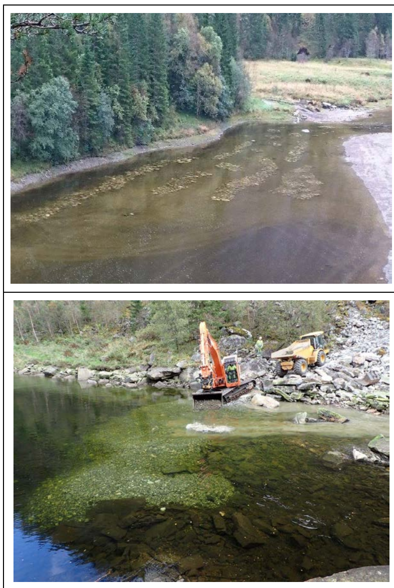
Steinrekkene synes godt og de danner hulrom for ungfisk i et område som bar preg av å være et dårlig oppvekstområde. Samtidig fungerer de som skjul for voksenfisk. Gytegrus ble lagt ut i det området hvor terskelen lå tidligere. I dag er området egnet for gyting.
