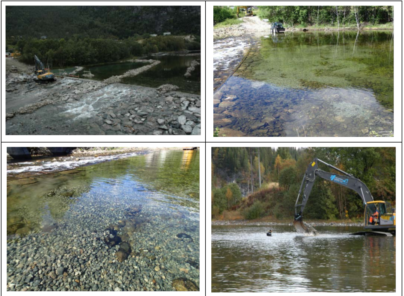
Figur 13. I forbindelse med den nye terskelen som ble etablert i hovedløpet nedstrøms Myster kraftstasjon i Ekso sommeren 2008, ble det i både 2013 og i 2014 lagt ut egnet gytegrus.
