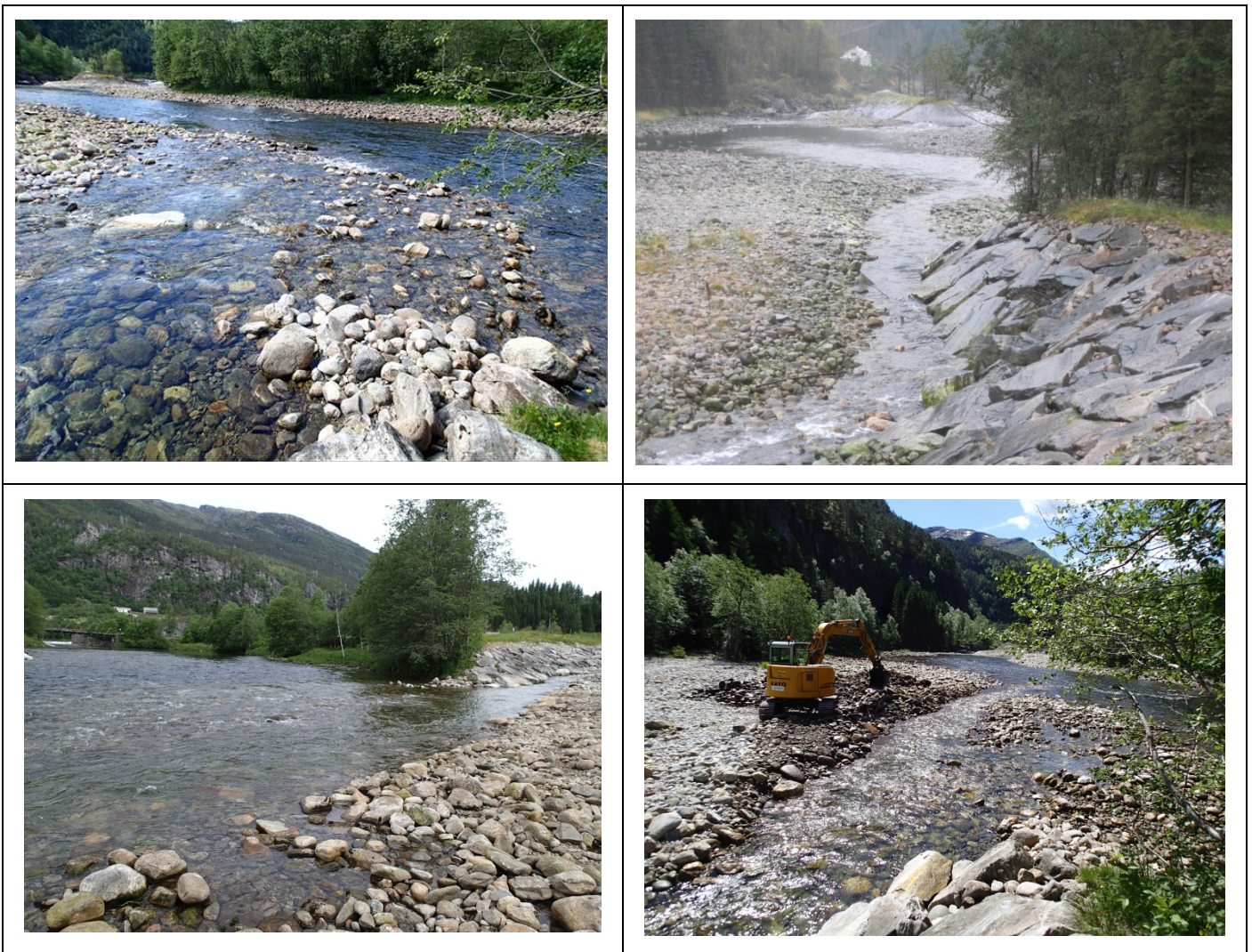
Figur 12. Samløpet mellom Leiro og hovedløpet i Ekso ble utbedret ved å grave en definert dypål inn i Leiro sommeren 2013. Tiltaket har trolig forbedret konnektiviteten for både ung- og voksenfisk mellom hovedløpet og denne sideelven.
