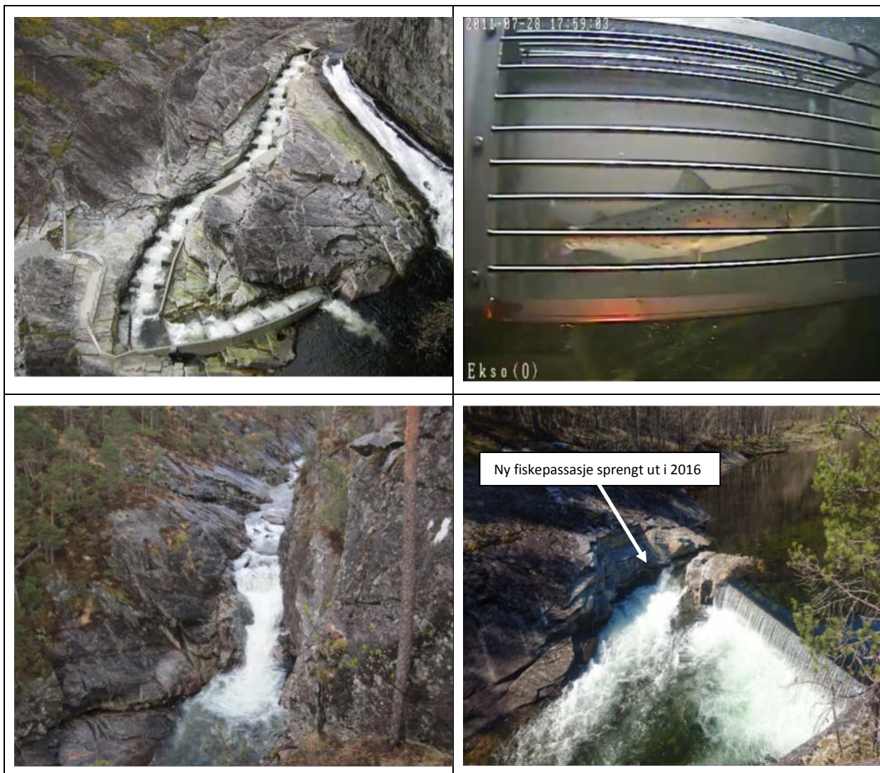
Figur 18. Lakseførende strekning ble forlenget ved laksetrappen i Raufossen (øverst til venstre) hvor det og ble installert en fisketeller med videokamera (øverst til høyre). I Høsefossen har det blitt prøvd å utbedre vandringsveien for fisk uten suksess (nederst til venstre), mens vandringshinderet oppstrøms Høsefossen ved Sikjefossen er fjernet ved å lage en ny vandringsvei (nederst til høyre).
