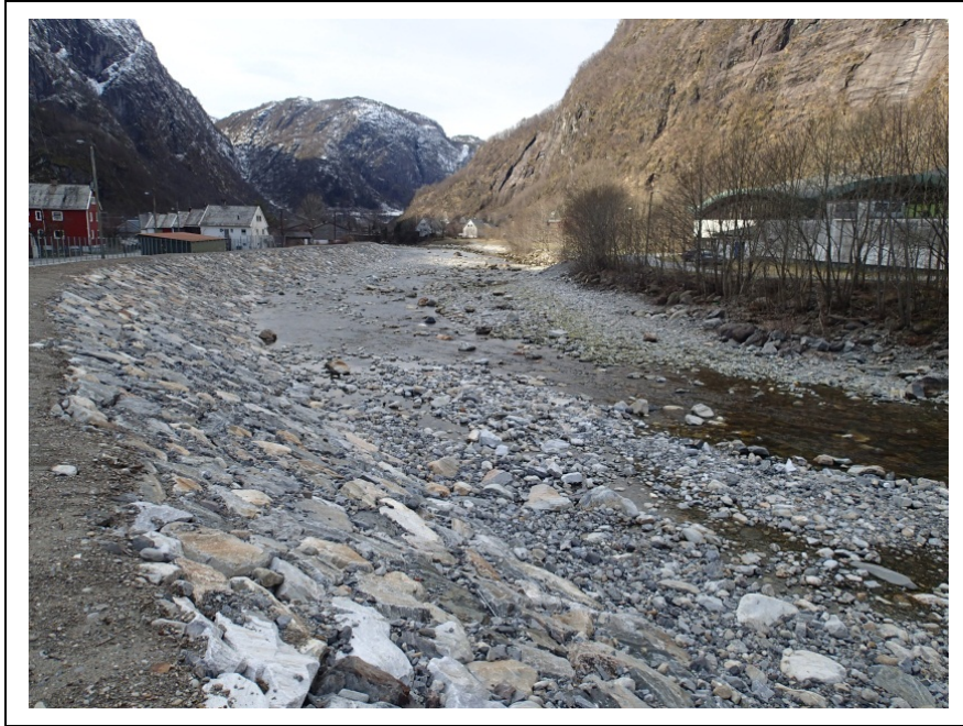
Deler av restfeltet slik det så ut etter at flomsikringsarbeidet var ferdig i 2014.
