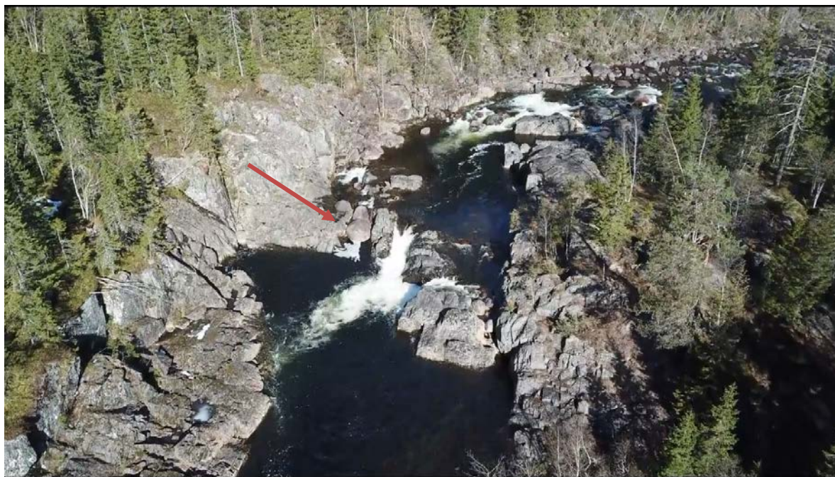
Figur 33. Dronebildet av Statkraft på 4 m 3 /s. Det estimeres at fossen får overfall over merket området ved ca. 7 m 3 /s. Det kan heller ikke utelukkes at fisk kommer seg opp de andre fossene ved lavere vannføringer.
